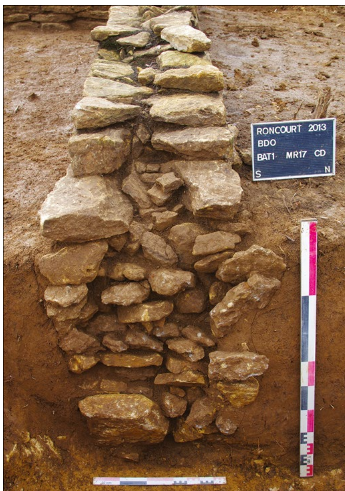
Fig. 12 – Profil du mur 17 du bâtiment 1 du site du Bois des Olivettes, vu depuis l'ouest (cliché: S. Sedlbauer).
