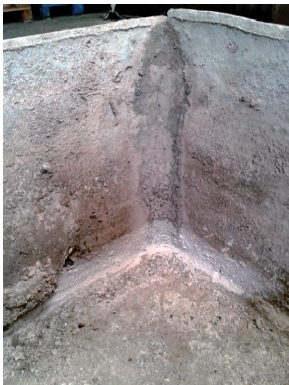
Fig. 32 - Soudure du sarcophage I1069 de type As2 où le cordon est aminci, formant un arrondi à l'intérieur de l'arrête (© Pierre-Emmanuel GILLET).
