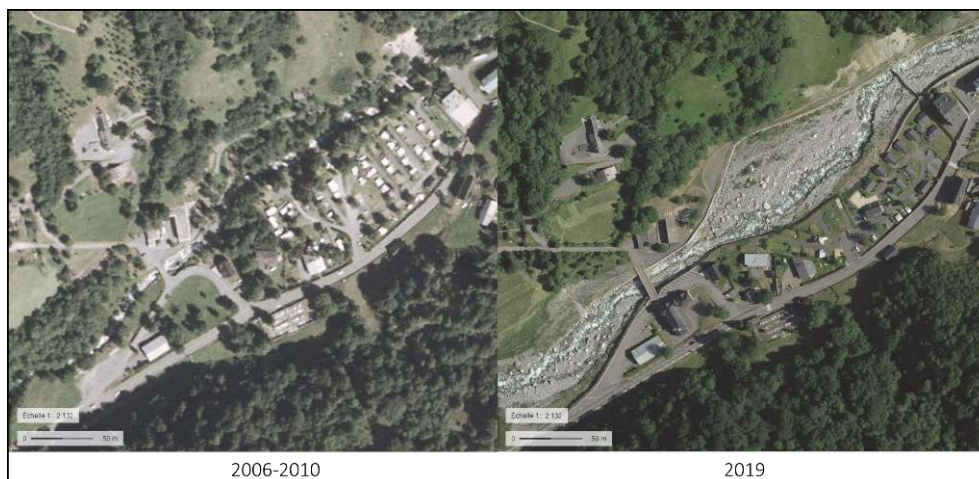
Figure 12. Elargissement du lit du Bastan et réduction de la taille du camping à Barèges
