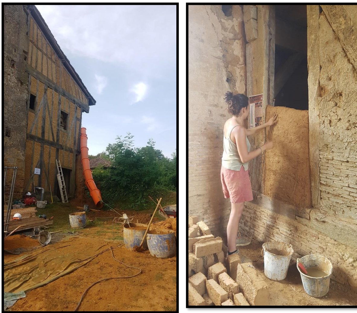
Fig. 1 et 2 : Chantier de reprise de l'angle nord-ouest du rempart en terre crue et reprise des hourdis de torchis (A. Champagne)
