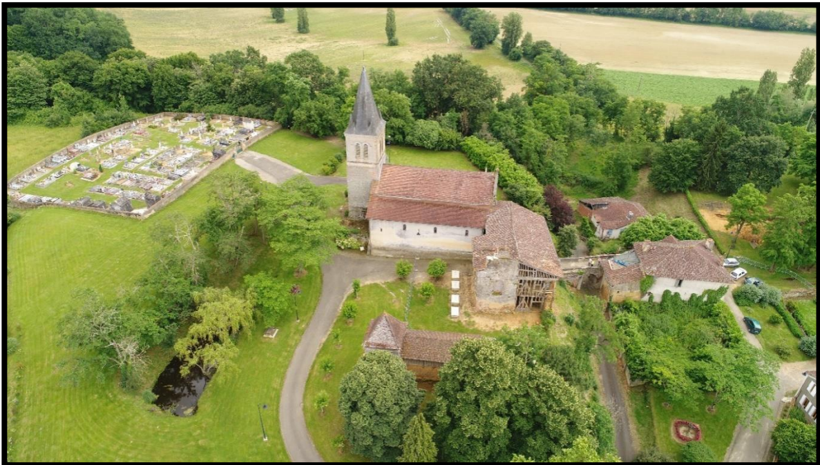
Fig. 9 : Vue par drone du castet en direction du sud (de gauche à droite, cimetière actuel, église, logis à pan de bois, fossé et pont (chemin communal), presbytère) (Cliché S. Durand).
