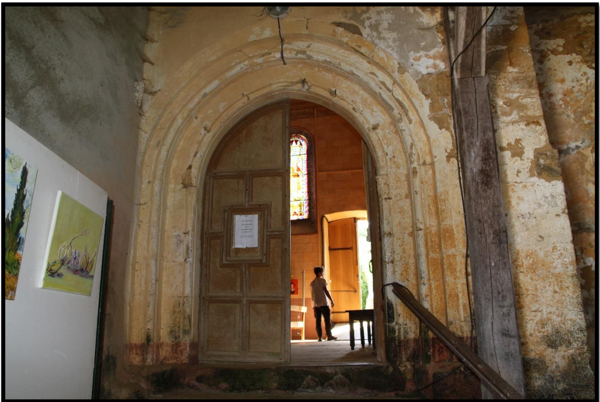
Fig. 51 - Vue du portail nord de l'église Saint-Pierre
