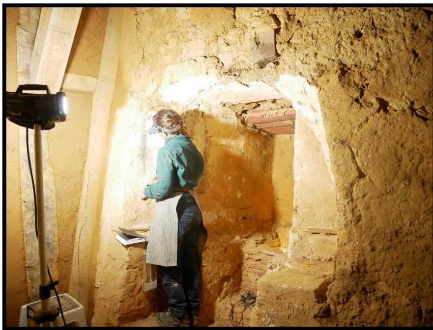
Fig. 19 – Analyse stratigraphique des enduits des latrines
