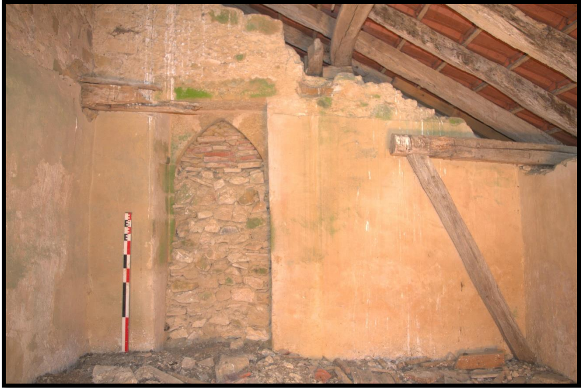
Fig. 63 - Vue du mur parement intérieur du mur ouest de la tour
