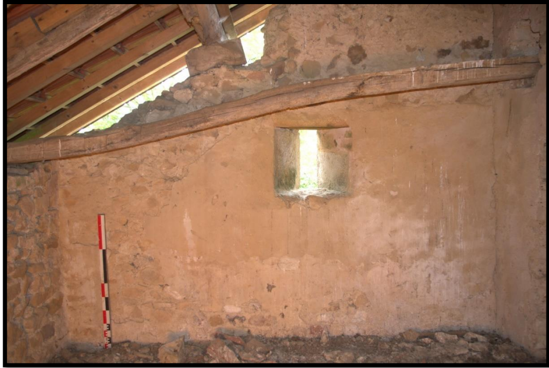
Fig. 60 - Vue du parement intérieur du mur est de la tour et de sa fenêtre
