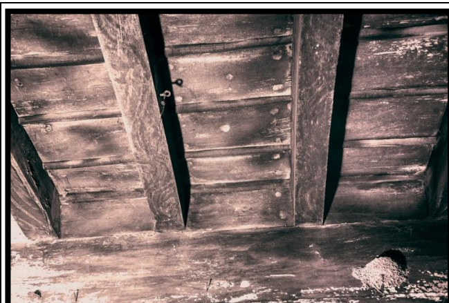
Figure 24 : Prise infra-rouge de la poutre P11a (C2)
