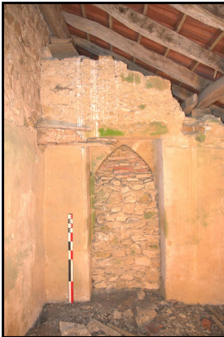
Fig. 65 - Vue de la porte ouverte dans le mur ouest de la tour
