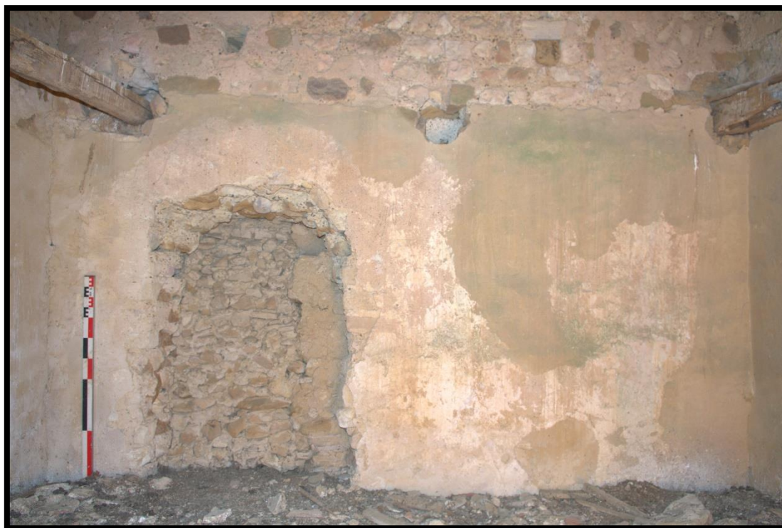
Fig. 73 - Vue de l'enduit appliqué sur le parement extérieur du mur nord de l'église Saint-Pierre
