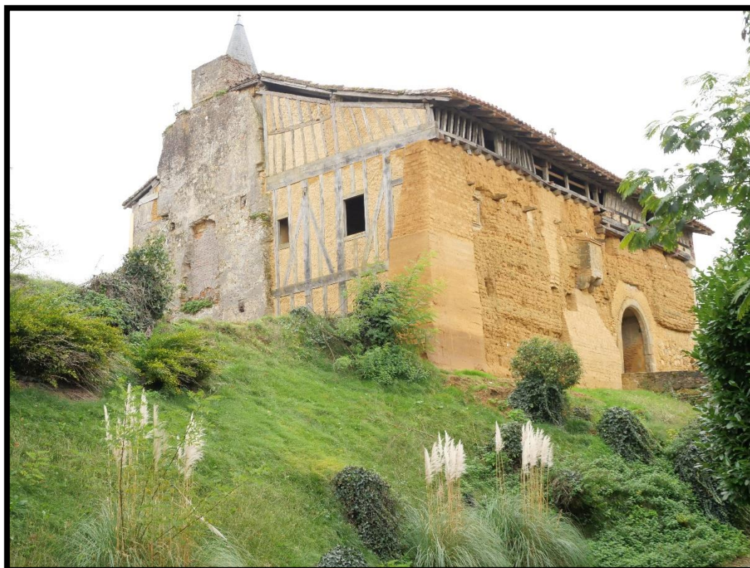
Fig. 3 : vue de l'angle nord-ouest du logis après restauration (A. Champagne)
