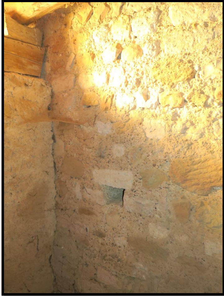
Fig. 44 - Vue du troisième trou de boulin
