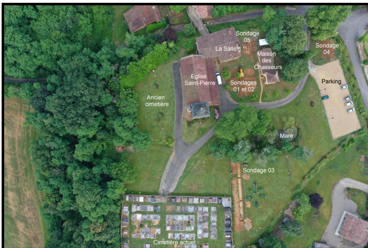
Fig. 13 - Cliché par drone du secteur d'intervention et localisation des sondages réalisés en 2021 (cliché : S. Durand ; DAO : N. Guinaudeau)
