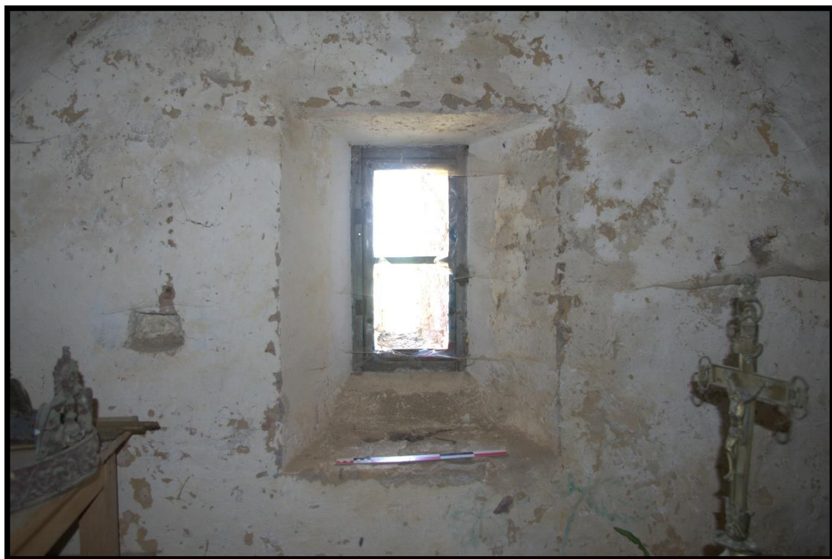
Fig. 56 - Fenêtre ouverte au premier niveau de la tour
