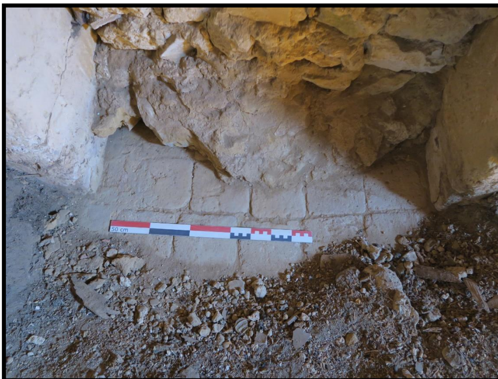
Fig. 71 - Vue des carreaux de terre cuite aménagés dans l'embrasure de la porte ouverte dans le mur ouest de la tour
