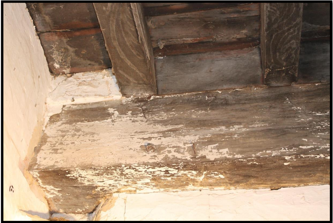
Figure 27 : Éléments peints en rouge puis en bleu dans la chambrette C2
