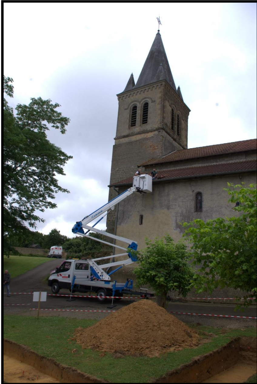
Fig. 39 - Accès à l'étage de la tour nord-est à l'aide d'une nacelle
