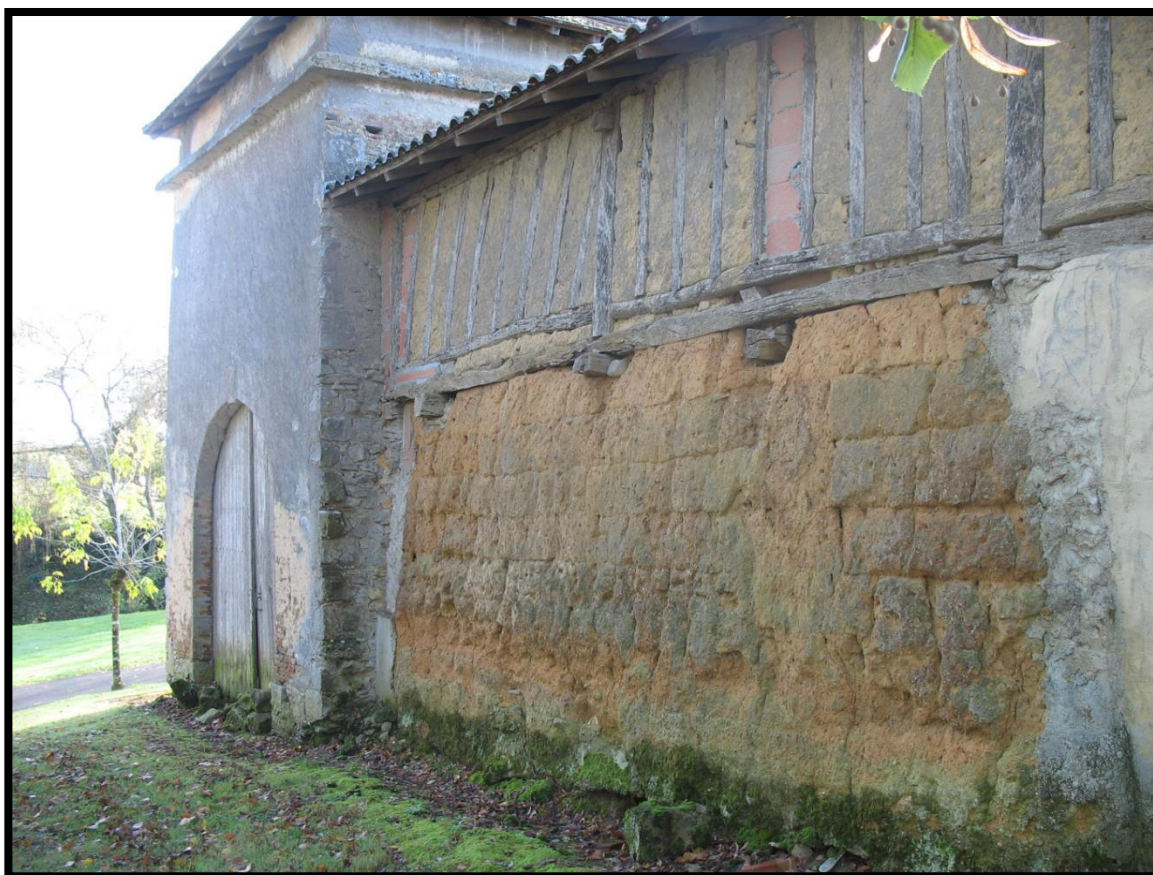
Fig. 10 : Photographie du mur en terre massive et de la porte visibles à l'extrémité nord de plate-forme du Castet, prise depuis le nord (cliché : N. Guinaudeau)
