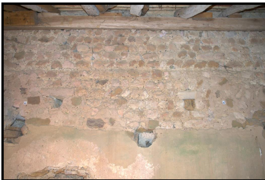
Fig. 43 - Vue du parement extérieur du mur nord de l'église Saint-Pierre
