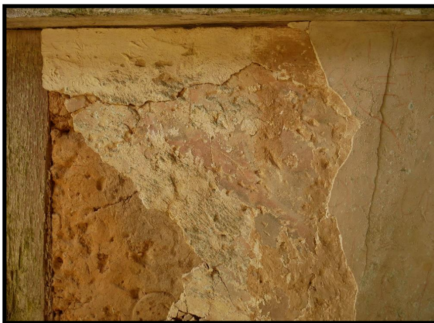
Fig. 20 : Décor de rinceau dans la cage d'escalier (mur sud, 1 er étage)
