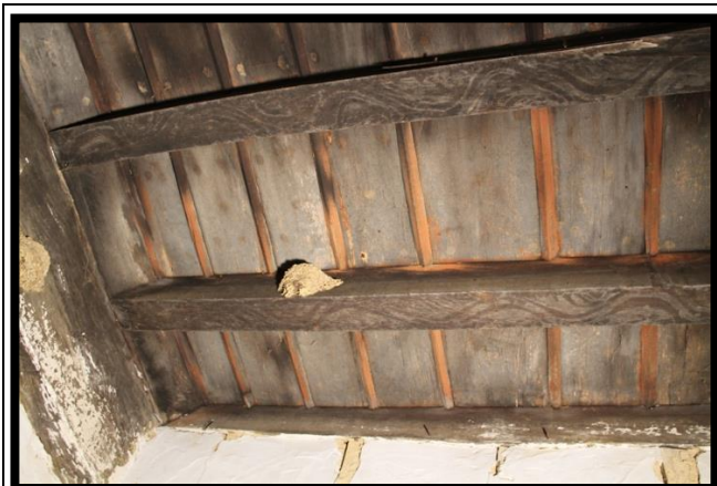
Figure 23 : Prise lumière visible de la poutre P11a (C2)
