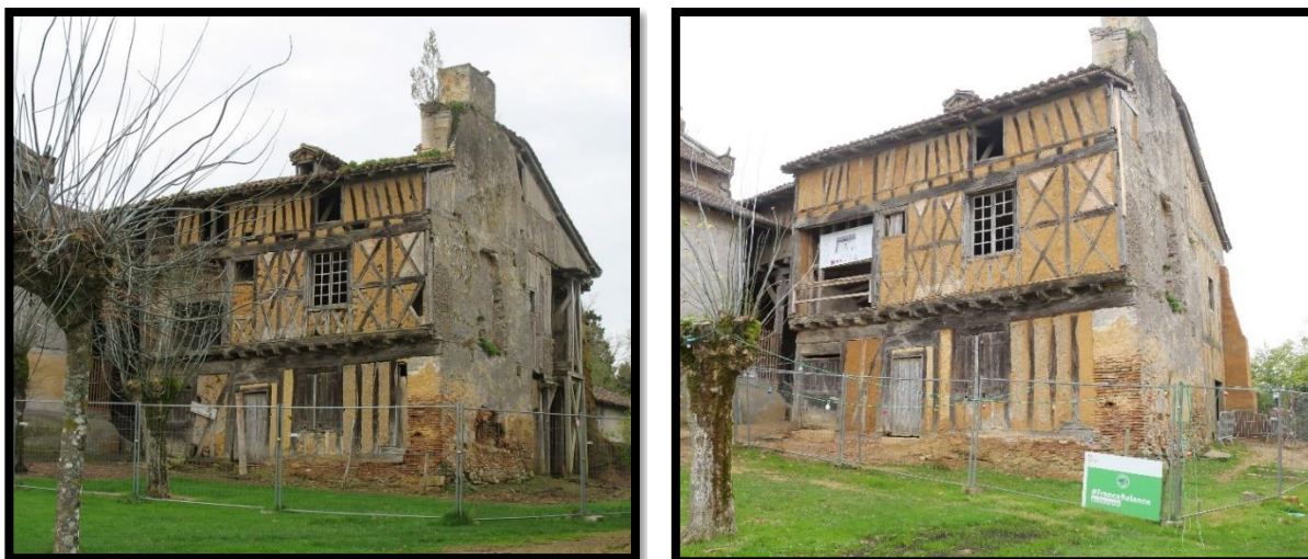
Fig. 4 et 5 : façade orientale du logis avant et après travaux sur les hourdis (A. Champagne)
