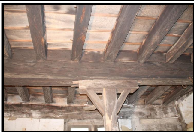
Figure 25 : Vue en lumière visible des poutres P111a et P1Va
