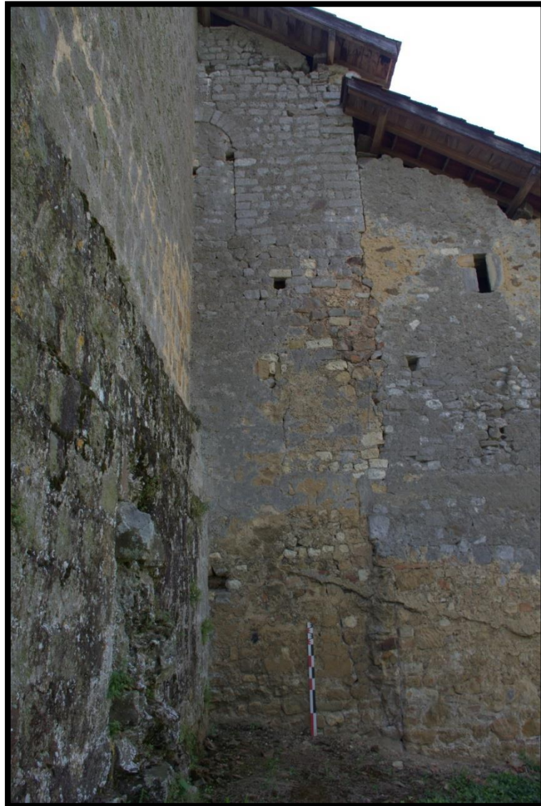
Fig. 40 - Vue du mur en petit appareil au chevet de l'église Saint-Pierre
