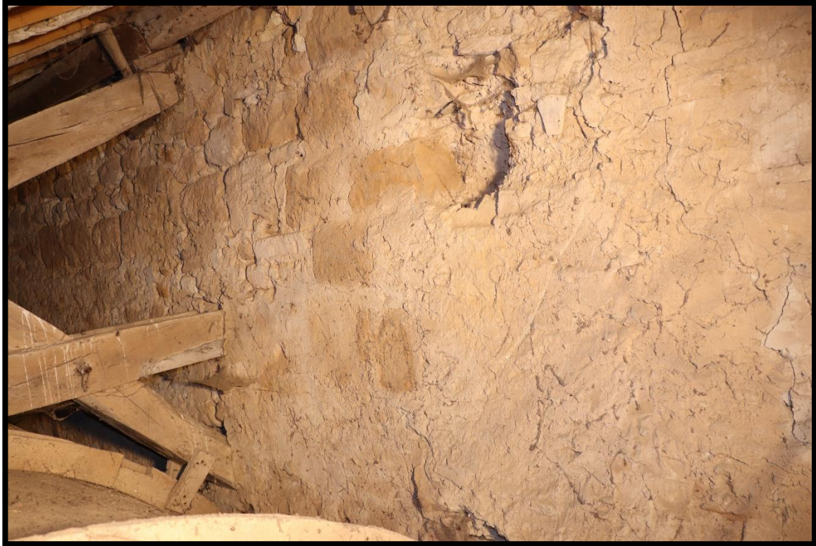
Fig. 50 - Vue du mur gouttereau nord de la nef
