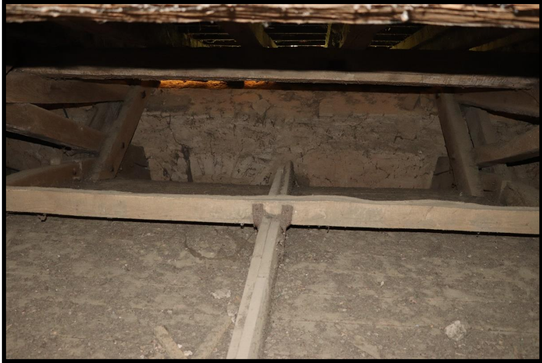
Fig. 75 - Vue de l'arc de la fenêtre ouverte dans le mur gouttereau sud de l'église Saint-Pierre
