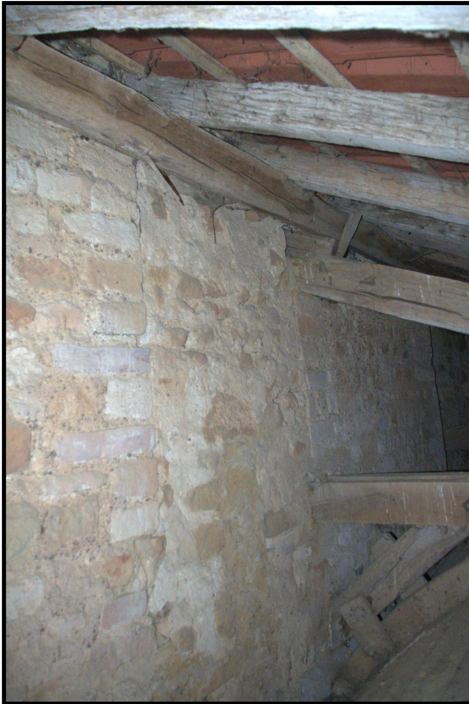
Fig. 46 - Vue de la fenêtre ouverte dans le mur nord de l'église Saint-Pierre
