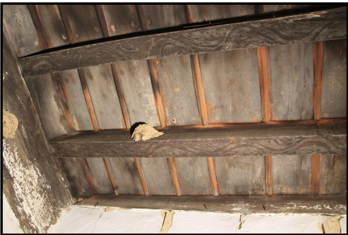
Figure 28 : Les couvre-joints et plancher de la chambrette C2
