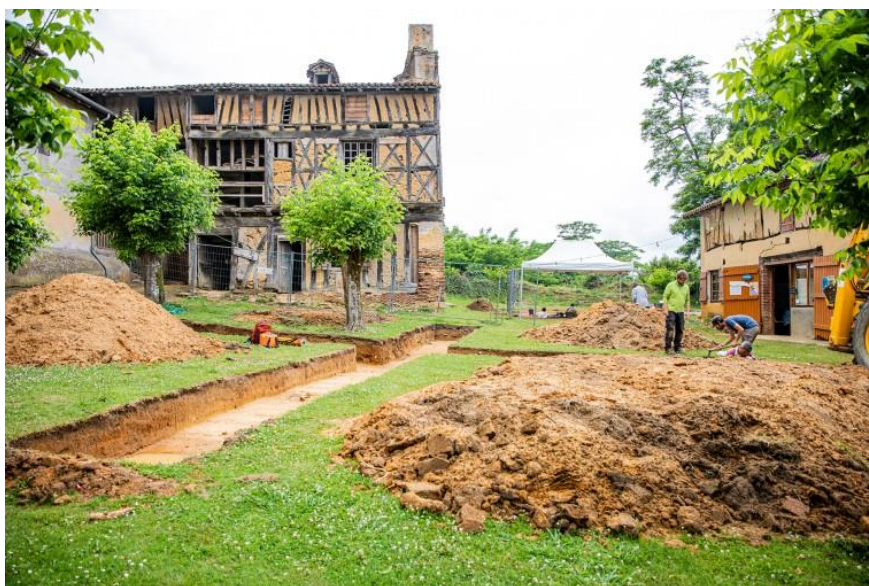
Vue du chantier
