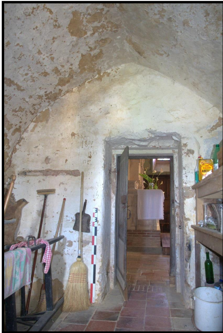
Fig. 72 - Porte percée dans le mur nord de l'église Saint-Pierre
