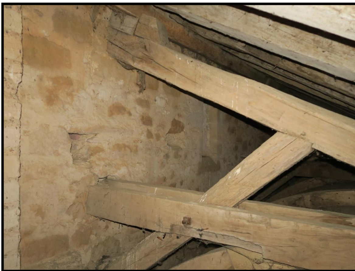
Fig. 49 - Vue du mur gouttereau nord de la nef et de sa fenêtre
