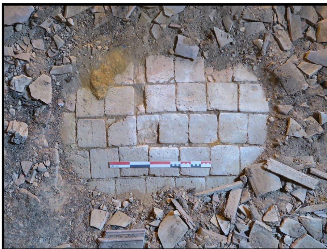
Fig. 70 - Vue des carreaux de terre cuite formant le sol du niveau supérieur de la tour
