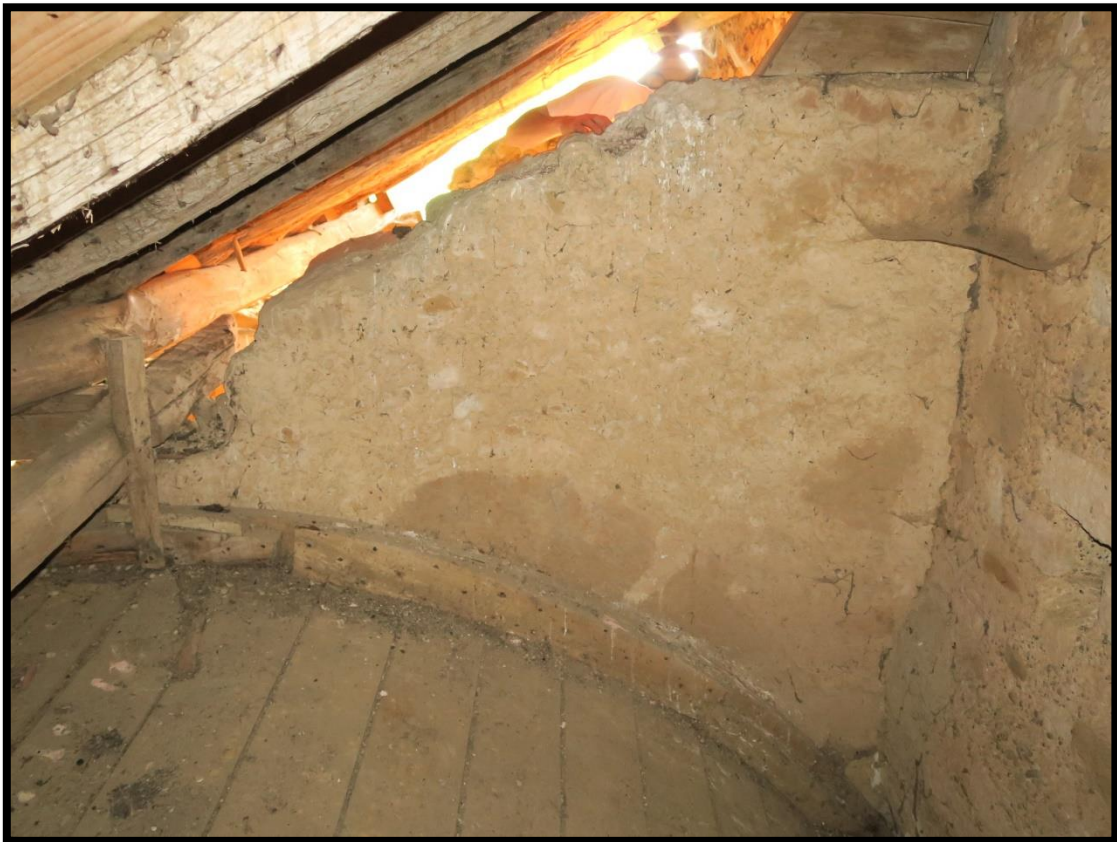
Fig. 64 - Vue de la partie supérieure du parement extérieur du mur ouest de la tour
