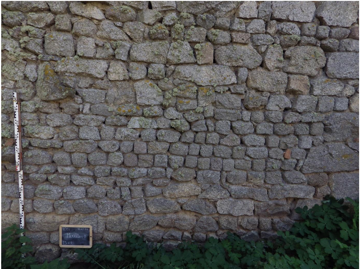
Figure 12 : Photographie de la façade Nord de la maison 1 au Boueix
