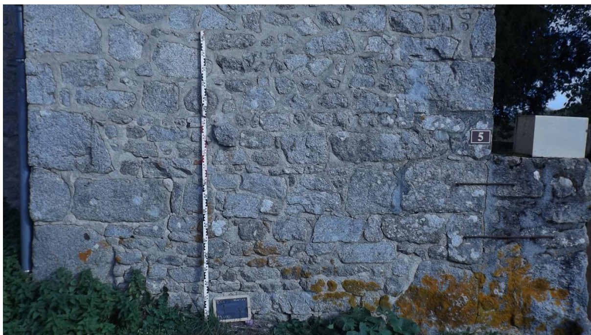
Figure 15 : Photographie de la façade Ouest de la maison 3 au Boueix
