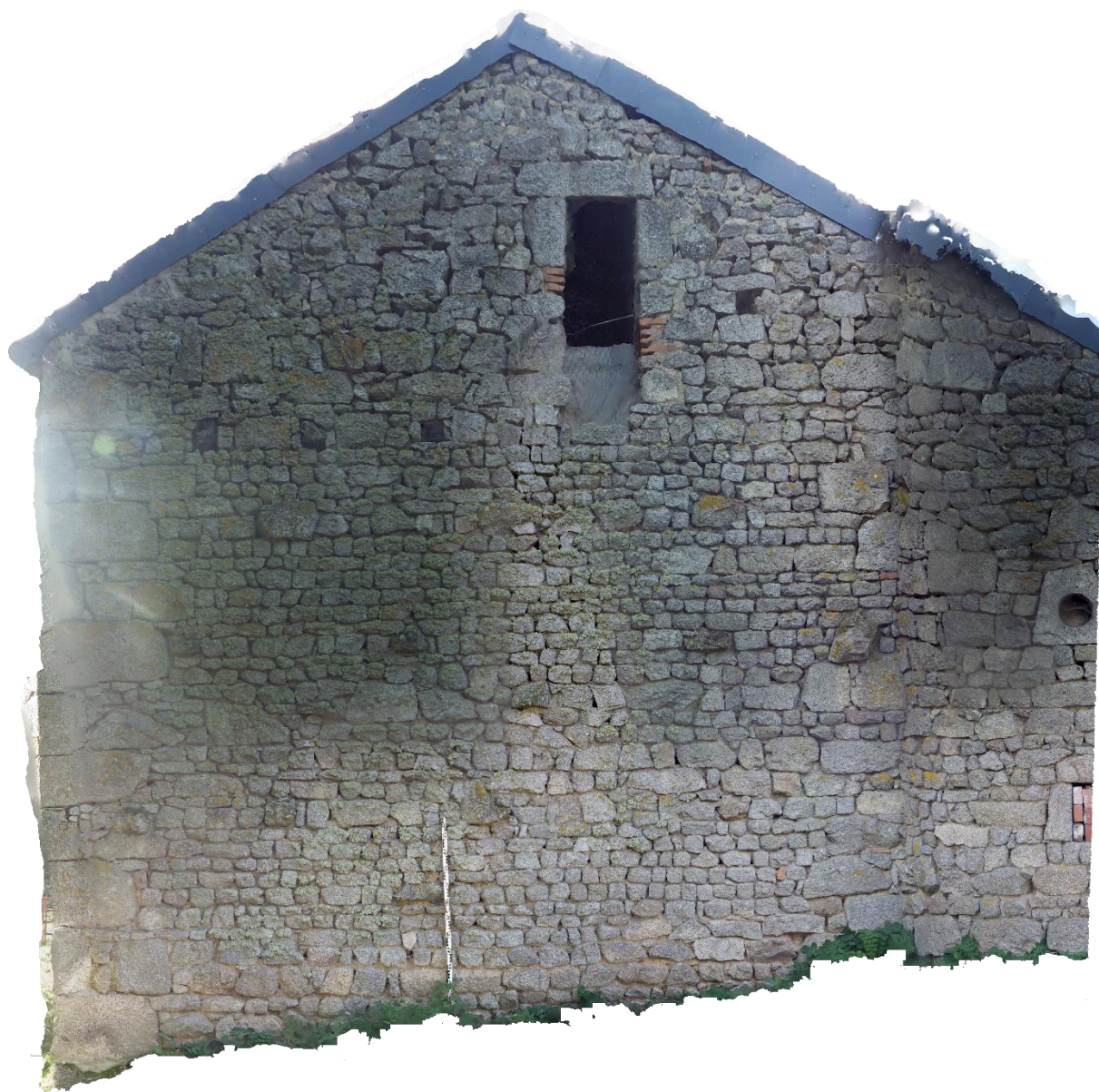
Figure 14 : Photogrammétrie du mur Est de la maison 2 au Boueix (M. Bourdoux)
