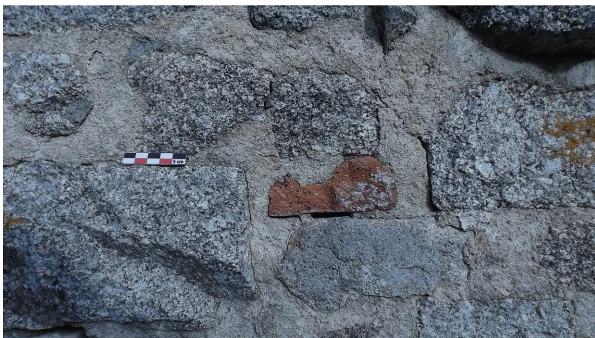
Figure 16 : Photographie d'une TCA prise dans la façade Ouest de la maison 3 du Boueix
