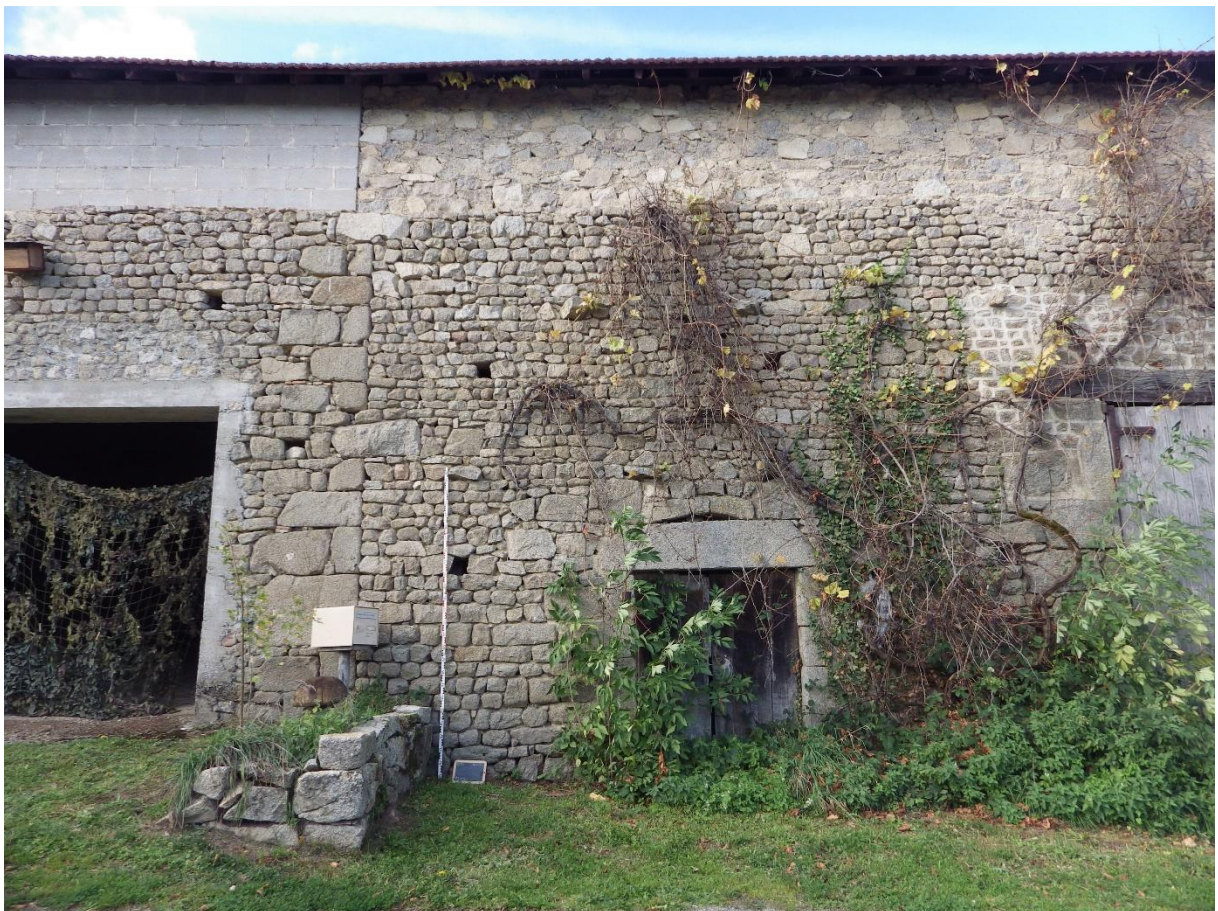
Figure 13 : Photographie de la façade Sud de la maison 1 au Boueix
