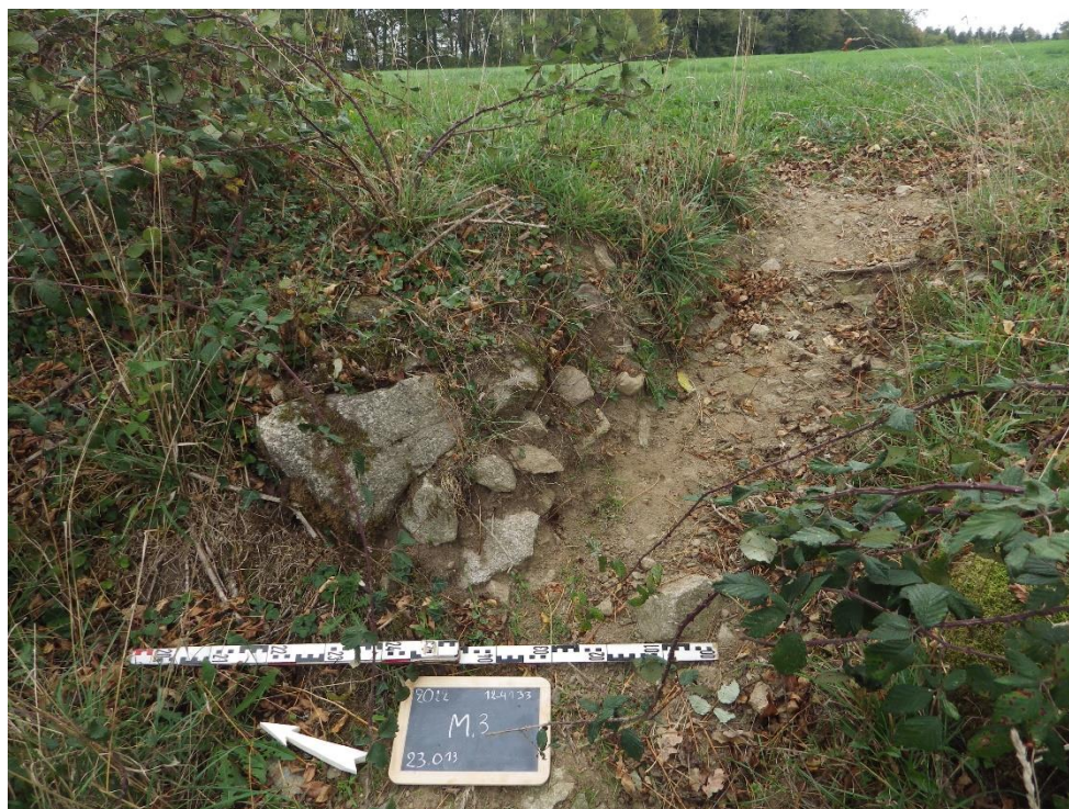
Figure 25 : Photographie du mur 3 observé à la limite des parcelles AW 0209 et AW 0204
