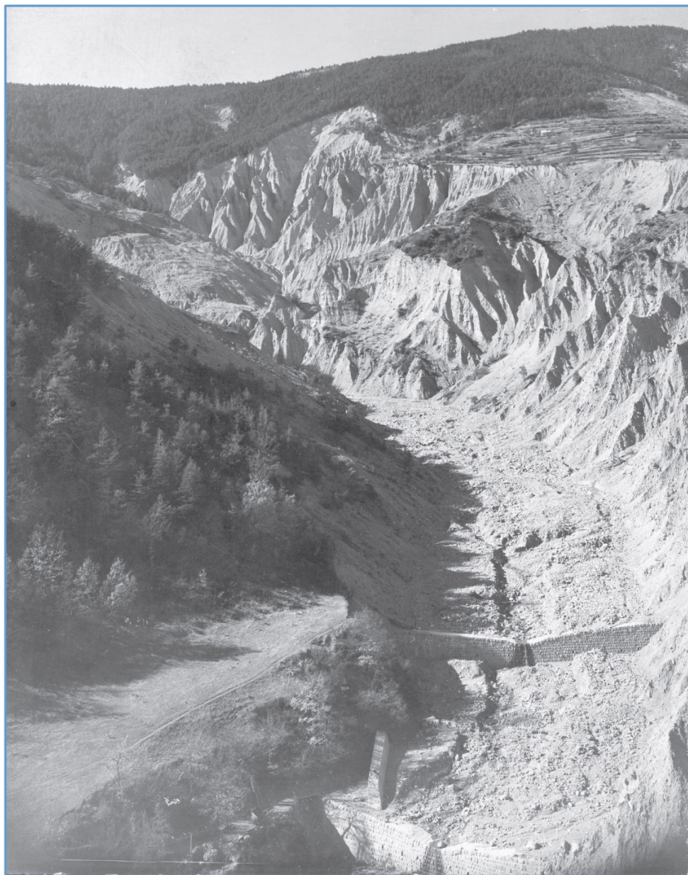
Vue d'ensemble du bassin du Réal en amont des barrages n°3 et 4 Flekcher Mars 1938
