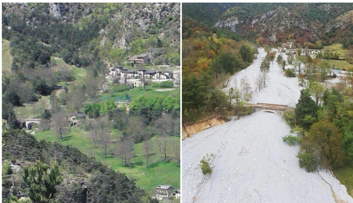
Le lit de la Roya amont à proximité de la Madone de Véivola. En haut : le cône de déjection engravé en amont du pont SNCF (source : V. KOULINSKI, 07/11/2020). En bas : le cône de déjection engravé au niveau du pont SNCF avant la crue (à gauche, source OBNF/RTM) ; après la crue, le 13 oct. 2020 (à droite, source : ONF-RTM).
