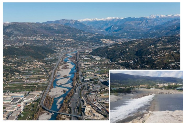
Tronçon restauré (basse vallée) et exemple de seuil
