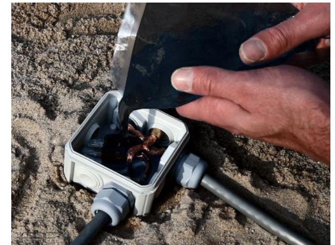
Coulage de boite de dér. avec résine
