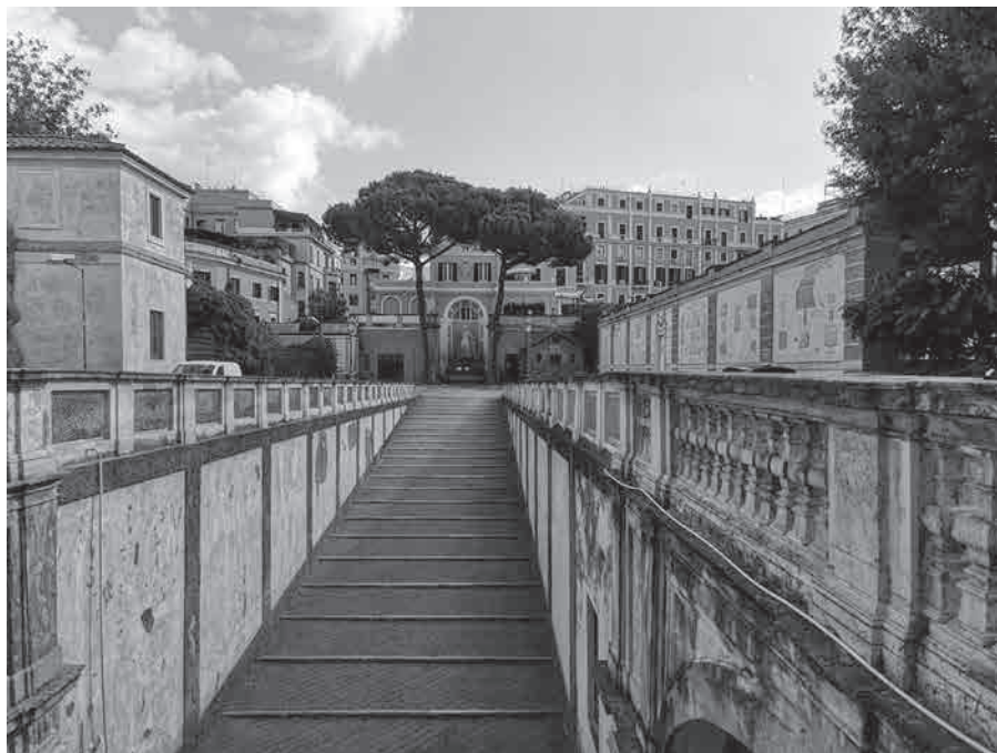
Figure 1 : L'escalier qui monte du palais Barberini vers le jardin. À droite la Casina et le mur arrière de la serre, au fond la statue d'Apollon et la palazzina Savorgnan di Brazzà
