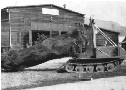
Fig. 1. Tracteur demi-porteur à chenilles souples « Motormuli ».
