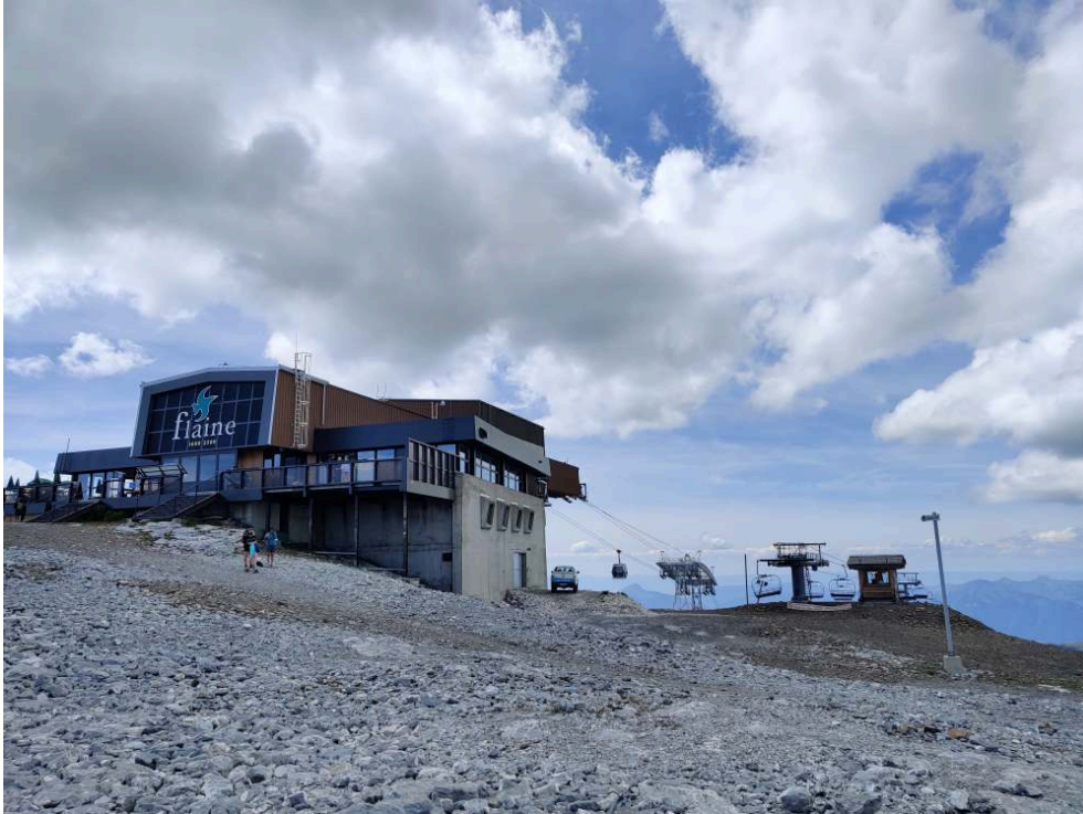
Figure 8. La gare d'arrivée du téléphérique, en limite de réserve
