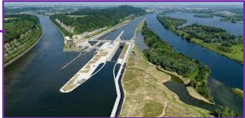
Refus d'investissement des autorités belges 3 jeux d'écluses : 1964 (de 450 à 1350 t) 4 ème écluse ; convois de 9000 t Wallonie 90% - Pays Bas 10%
