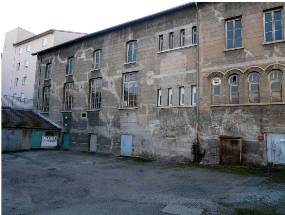
Façade arrière des bains-douches et du gymnase du Soleil, Saint-Étienne, 2022.
