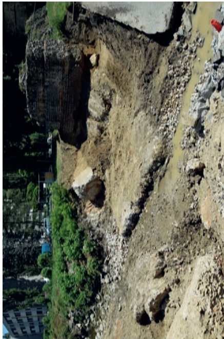
Fig. 5 – Vue d'ensemble de la pile 19 partiellement dégagée sur 1,20 m de profondeur (depuis le sud-ouest).
