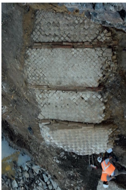
Fig. 4 – Bloc de maçonneries effondrées (vue du sud-est).
