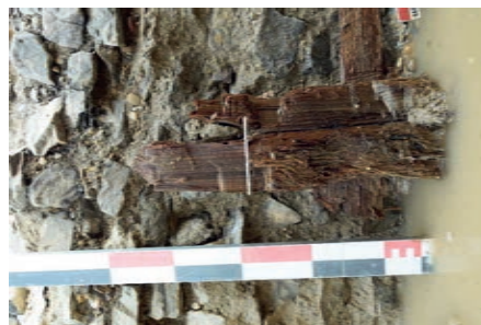
Fig. 6 – Pièces de bois contre le côté sud de la pile 18 (vue du sud)
