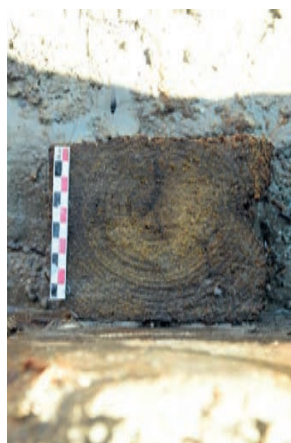
Fig. 3 - Vues du coffrage en bois de la pile 18 (vues du sud) et d'un détail de la section du pieu.
