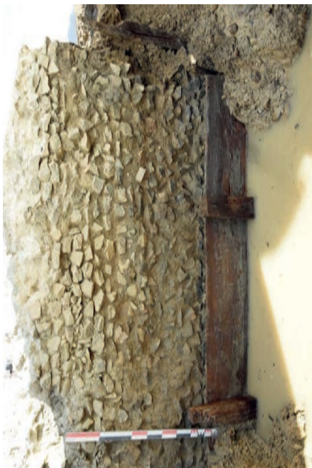
Fig. 3 – Planche et pierres en place sur le côté sud de la pile 18.
