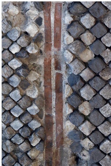
Fig. 5 - Appareil réticulé et arasé de briques de la pile 19 (J. Pessas)
