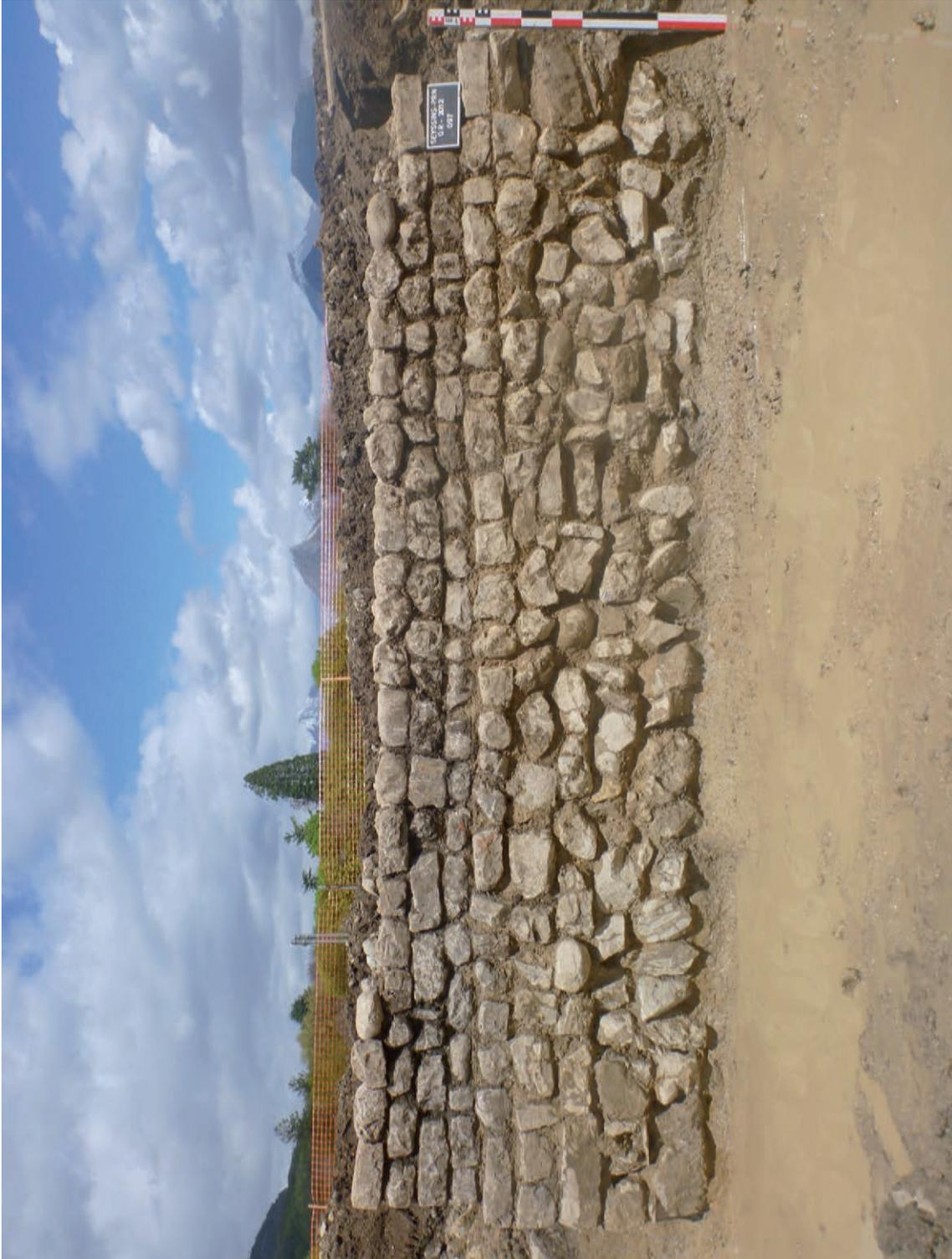
**Fig. 27 :** *Élévation et fondation du mur MR064 du bâtiment ENS 2 vu depuis le sud. (Cliché : Archeodunum).*
