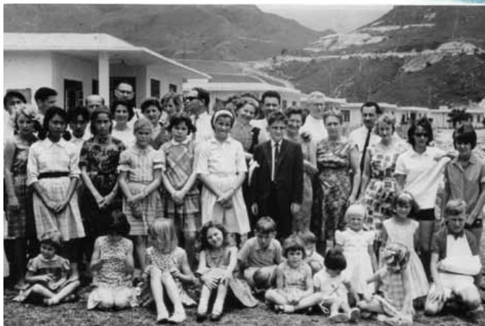
Les familles de la société Soletanche posent devant les maisons du village de Shek Pik. À l'arrière-plan, on devine le chantier du barrage.
