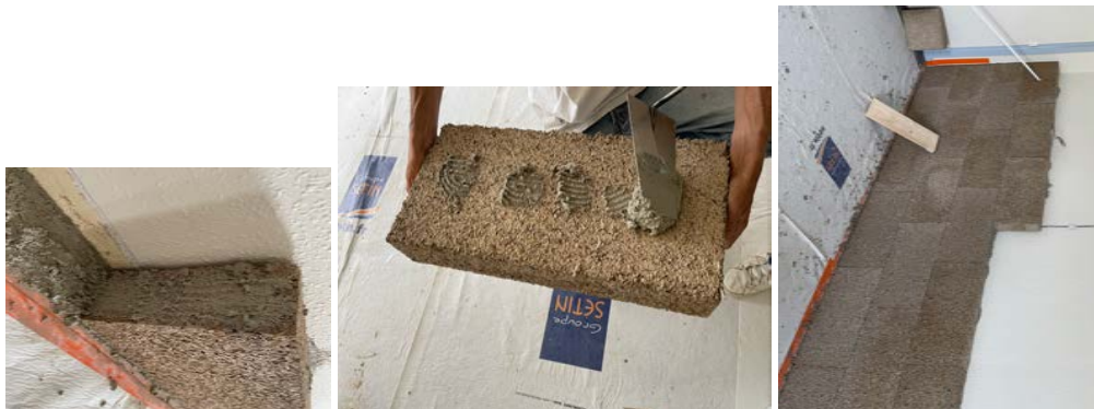
FIGURE 2. Montage du parement en béton de chanvre
