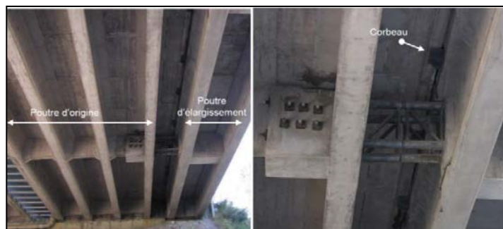
FIGURE 3. Travée de rive élargie avec zoom sur une entretoise métallique de liaison et des corbeaux métalliques d'appui
