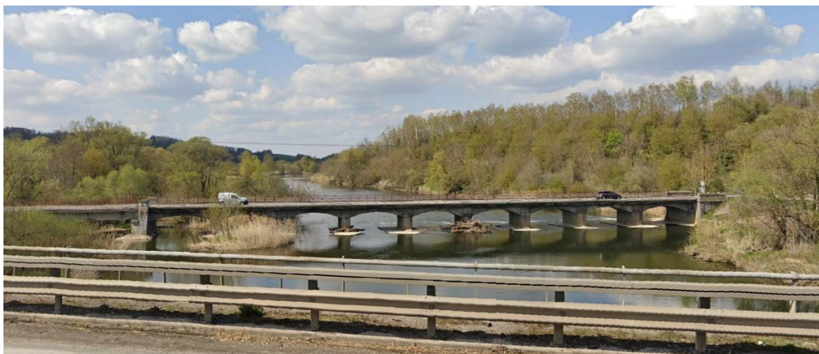
FIGURE 1 Ouvrage en béton armé existant
