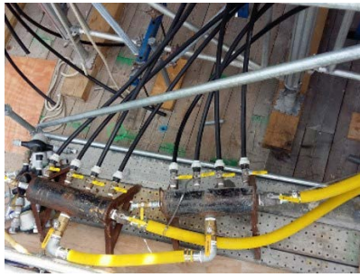
FIGURE 5. Mise en œuvre du système de post-refroidissement par eau externe
