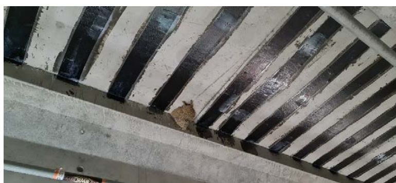
FIGURE 7. Calepinage des bandes composites en fonction des nids d'hirondelles rousselines
