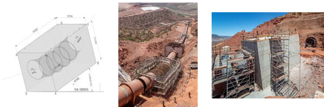
FIGURE 9. Description et réalisation d'un massif de déviation de la conduite forcée
