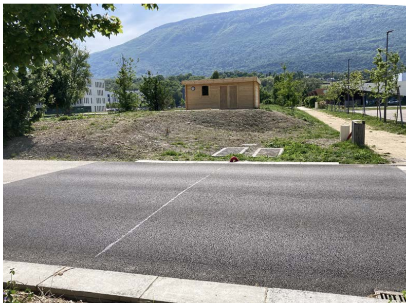
FIGURE 3. Chaussée récupératrice d'énergie du démonstrateur Dromotherm de Savoie Technolac
