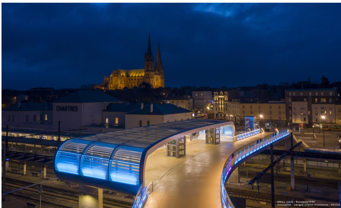
IMAGE 2. Passerelle de la gare de Chartres
