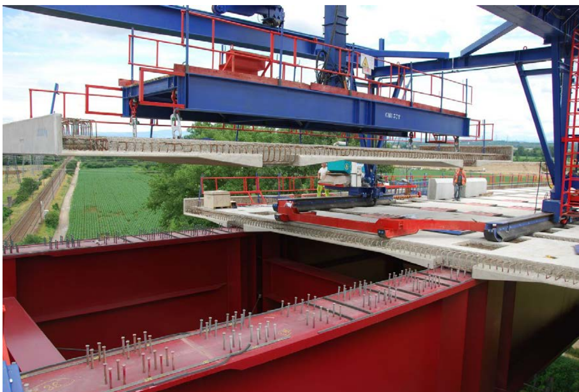
FIGURE 2. Bipoutre mixte / possibilité de poutres hybrides
