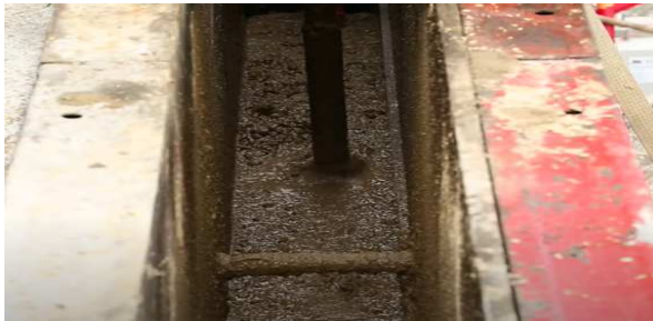
FIGURE 8. Centre technique – La Métro, construit en terre coulée [13]
