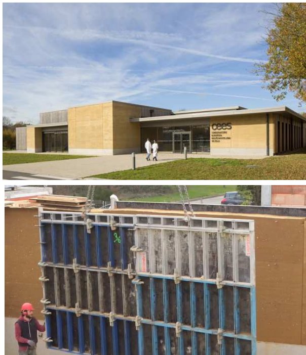
FIGURE 7. Conservatoire Européen des échantillons de sols, construit avec du pisé. [12]
