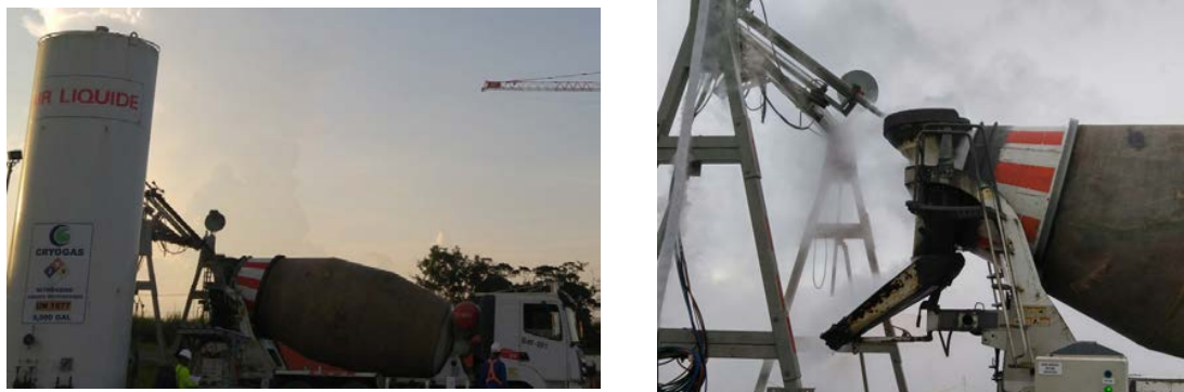
FIGURE 4. Refroidissement du béton à l'aide d'azote liquide
