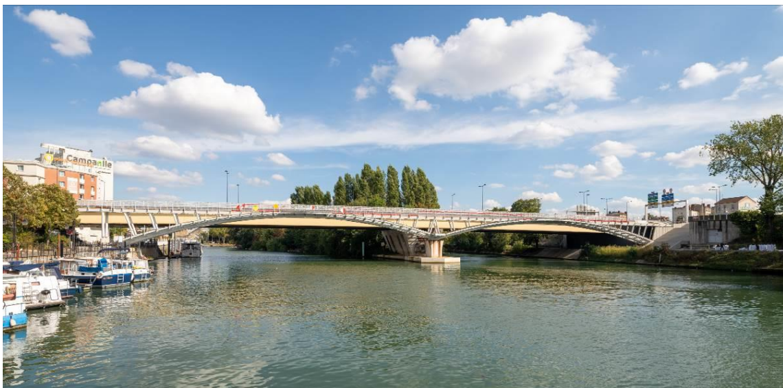
IMAGE 5. Passerelle de Nogent sur Marne – Antoine Duhamel photographe
