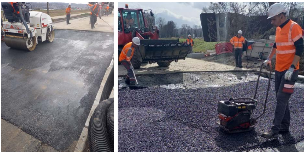
FIGURE 2. Réalisation de la chaussée récupératrice d'énergie du démonstrateur Dromotherm de Savoie Technolac (à gauche, cuvette d'enrobé étanche ; à droite, compactage de la couche d'enrobé drainant)
