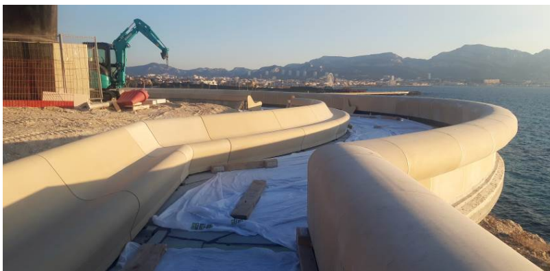
Figure 8 : Pose des bancs et parapets
