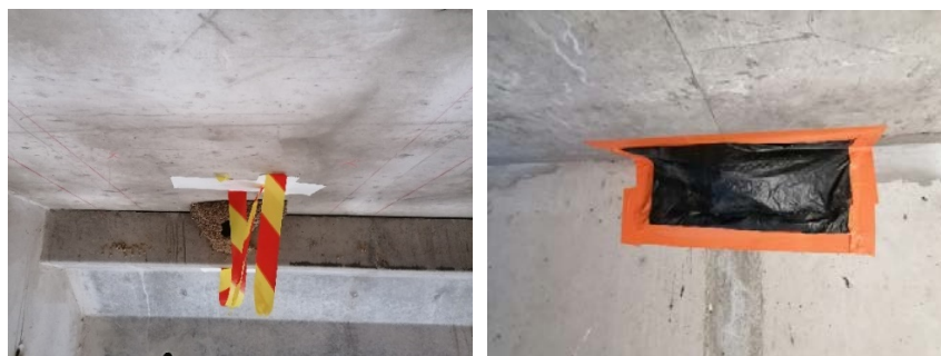
FIGURE 6. Protection et identification des nids d'hirondelles sous l'ouvrage
