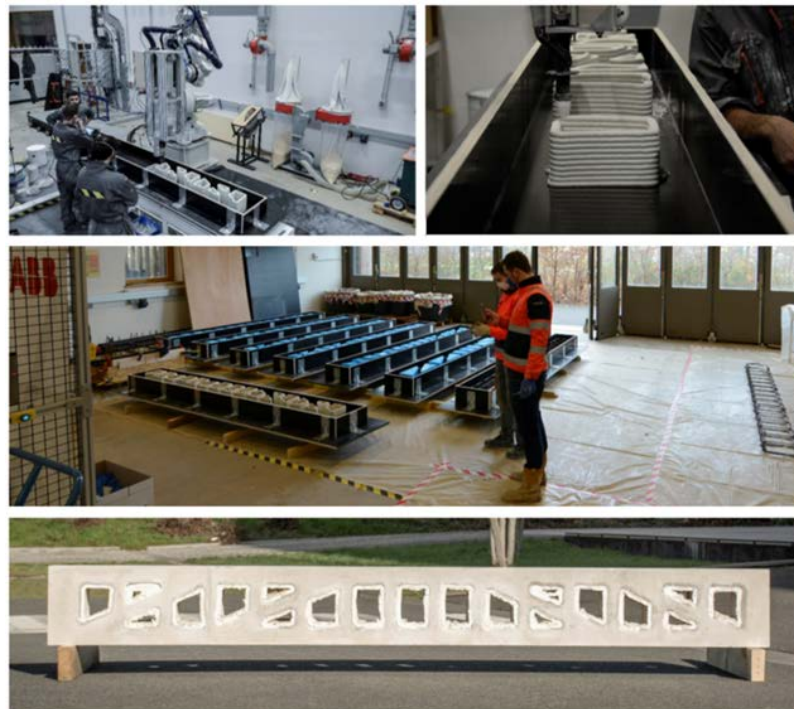
FIGURE 6. Fabrication du prototype. (haut) - Impression des moules. (milieu), insertion des armatures (à droite sur la photo). (bas) - Décoffrage de la poutre
