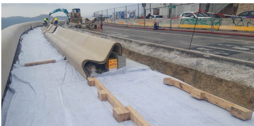
Figure 9 : Pose des bancs et parapets
