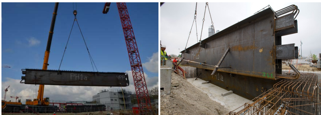
FIGURE 8. Installation de 10 poutres hybrides pour un franchissement RER à Noisy-le-Grand (93)
