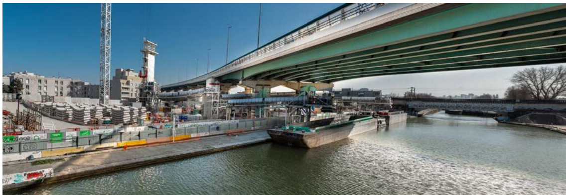
FIGURE 7. Evacuation des déblais par alternative fluviale 3303P
