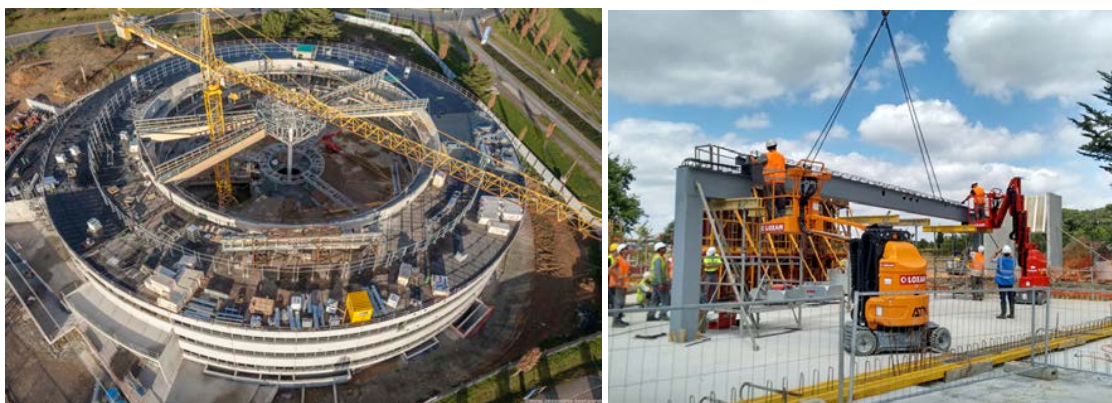
FIGURE 6. Construction du campus AVRIL à Bruz (35) [9] et installation d'une poutre hybride
