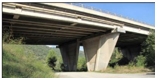
FIGURE 2. Vue des travées 1 et 2 coté Sud
