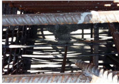
FIGURE 5. Mise en œuvre du système de post-refroidissement par eau externe
