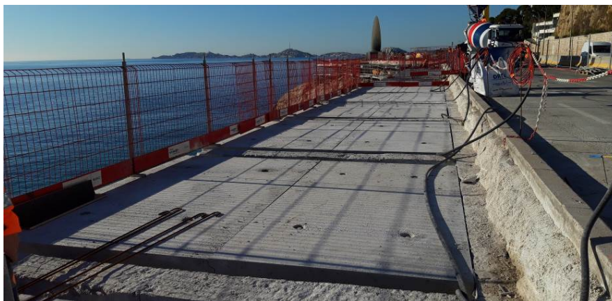
Figure 7 : Pose des dalles
