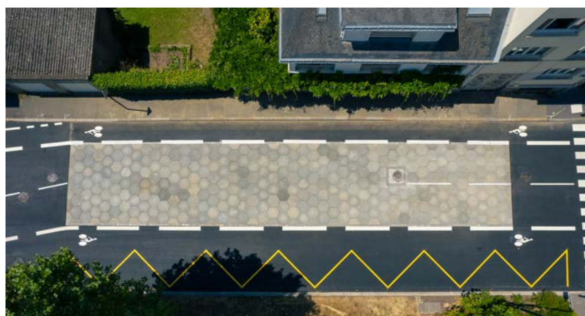
FIGURE 10. Aspect final du démonstrateur de CUD-SF (© Eiffage)
