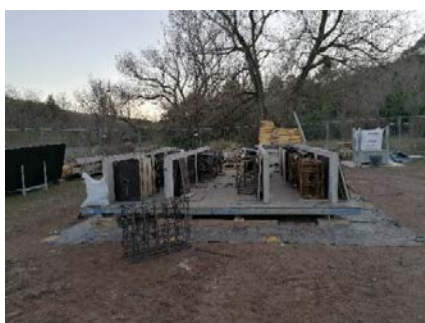
FIGURE 10. Aire de préfabrication des blochets
