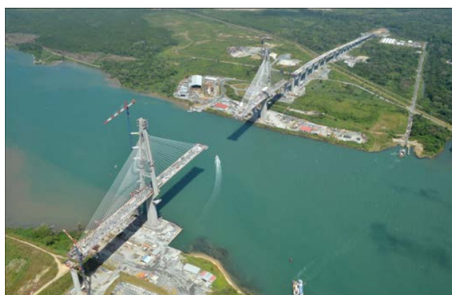
FIGURE 2. Vue générale du pont de l'Atlantique au Panama
