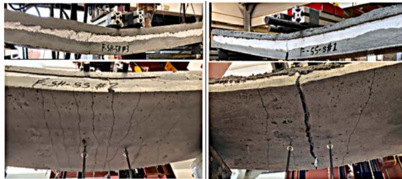
Figure 12 : Modes de ruptures des panneaux sandwichs [100]
