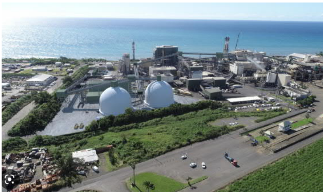
FIGURE 6. Domes stockage pellets de bois – Usine de Bois Rouge (Crédit IMAZ Presse Réunion)
