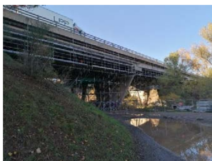
FIGURE 8. Vue de l'échafaudage sur le tablier Sud
