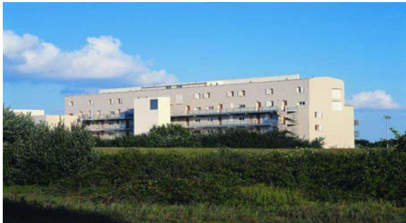
FIGURE 8. Centre technique – La Métro, construit en terre coulée [13]
