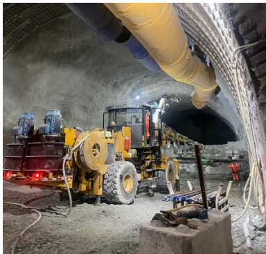
Figure 3 - Méthode conventionnelle (chantier TELT)
