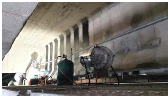
FIGURE 9. Pose des bandes composites avec chauffage d'appoint
