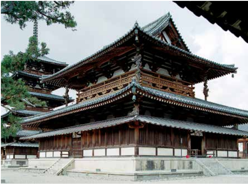
3. Pavillon majeur cultuel ( kondō ) du monastère bouddhique Hōryū-ji, VII e siècle, préfecture de Nara.
