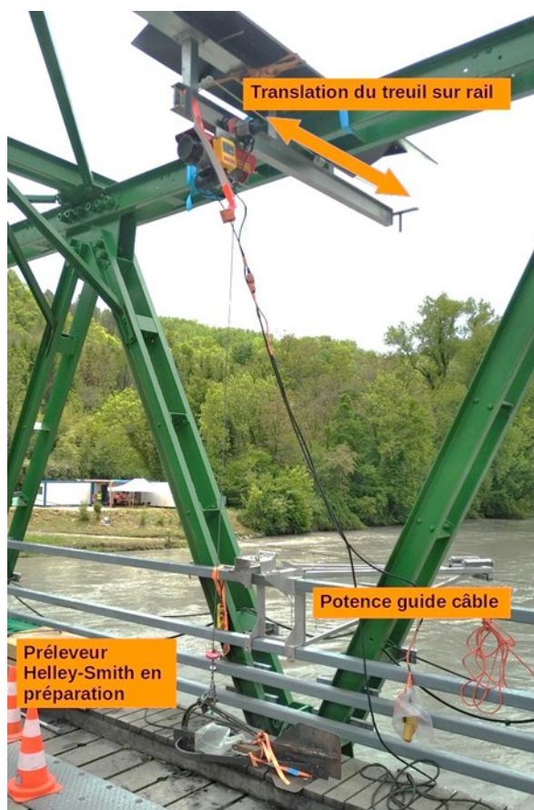
Figure 8: Dispositif de déploiement par treuil sur la verticale centrale du pont de Pyrimont.
