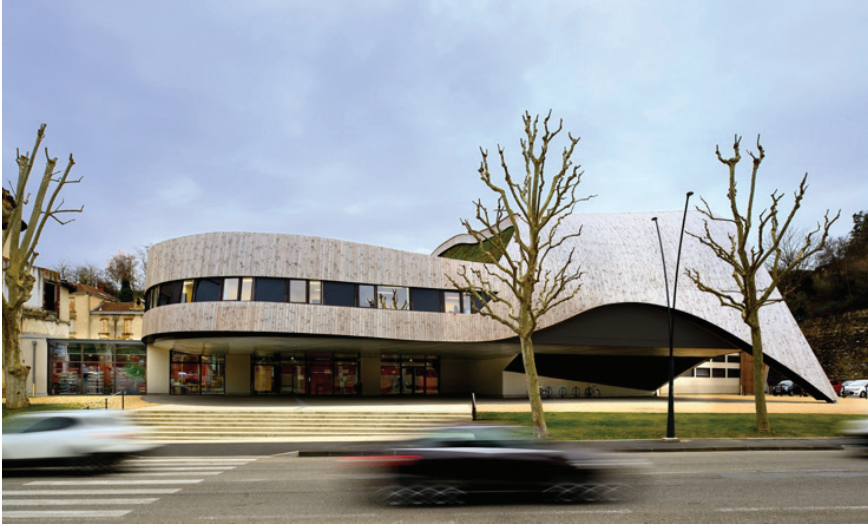
Fig. 1. Cité de la musique de Romans, côté entrée principale.
