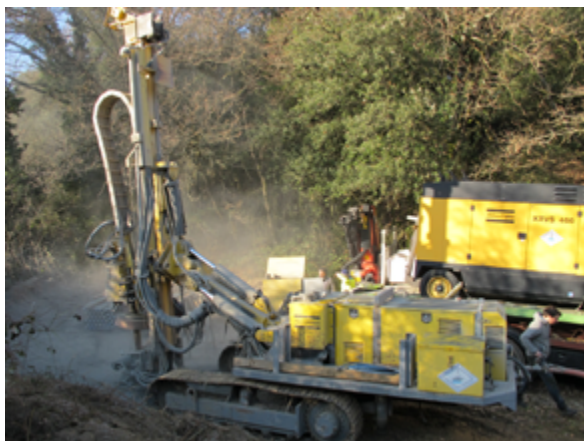
1 - Forage réalisé à proximité de la faille de la Rouvière, pour extraire une carotte de la zone de faille située à une quinzaine de mètres de profondeur.- janvier 2022 © V. Bertrand
