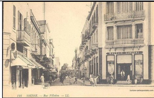
Fig5. VUE SUR LA RUE VILLEDON DANS LES ANNEES 1900, COMMUNE DE SOUSSE ( https://www.tunisie-cartespostales.com/sousse/ )
