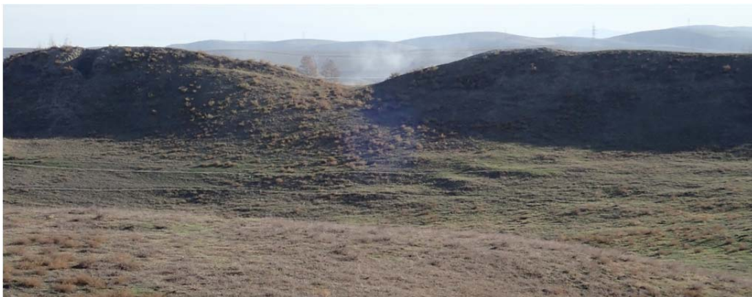
Рис. 15: Неповрежденные восточные ворота, между башнями Б8 (слева) и Б9, вид на восток, фото М. Желэн © ТФАМЮТ.
