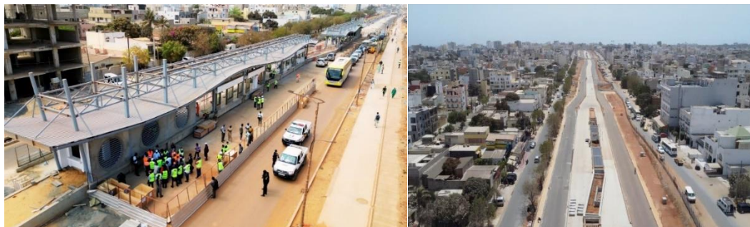
Photos n°3 et 4 illustrant les stations du BRT
