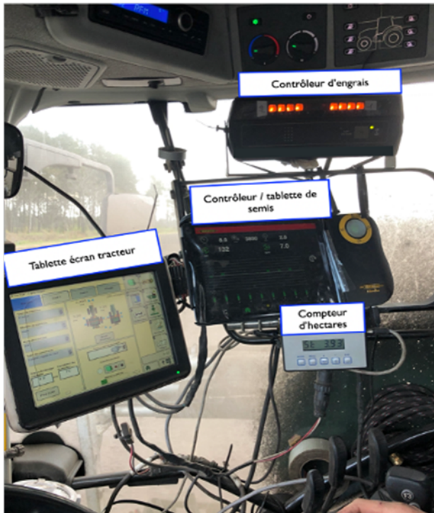
Figure 2 : Système technique installé dans la cabine d'un des tracteurs observe, © fotografia : Fredj
