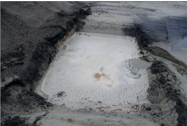
Ancien sondage 1022 à l'issue des intempéries du 06/03/2019
