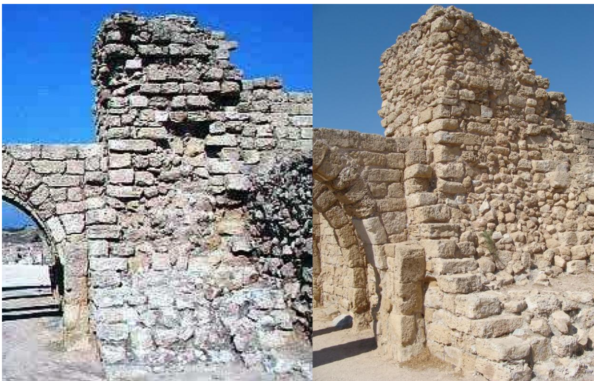
Figure 149 : Vue de la courtine primitive en coupe au Sud de T10, prise depuis le Sud-Ouest. La photo de gauche a été prise à une date indéterminée, avant les consolidations qui étaient intervenues en 2008 (photo de droite). On doit considérer les parements situés deux à trois assises au-dessus de la naissance de l'arcade (au premier plan) comme restitués après 1961. Noter le collage de la maçonnerie de l'épaississement Saint Louis contre le parement original, en bas à droite.
