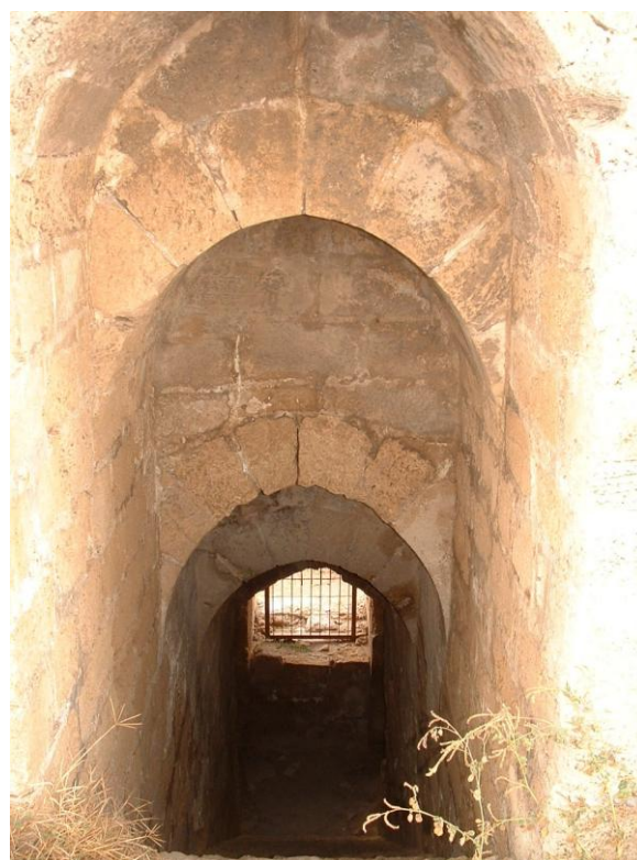
Figure 109 : Vue de l'escalier voûté de la poterne, prise depuis l'Ouest
