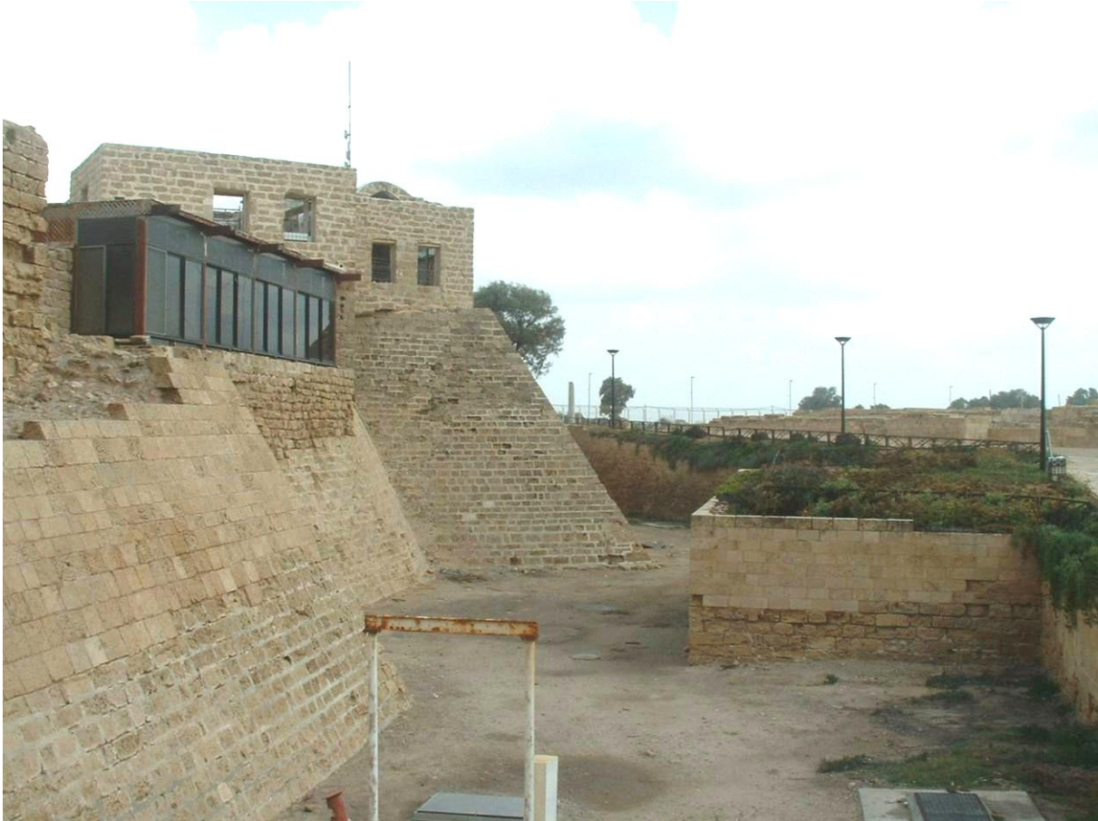
Figure 216 : Vue de la courtine 14-15 prise depuis l'Ouest
