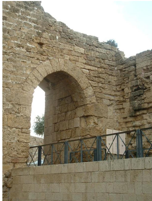
Figure 230 : Vue de la porte Sud-Ouest, prise depuis le Sud-Ouest
