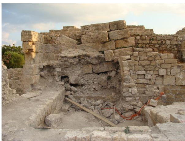
Figure 43 : Vue du mur M3 depuis le Sud en 2008, avant les consolidations de 2009 de la partie intermédiaire (UM 3001).
