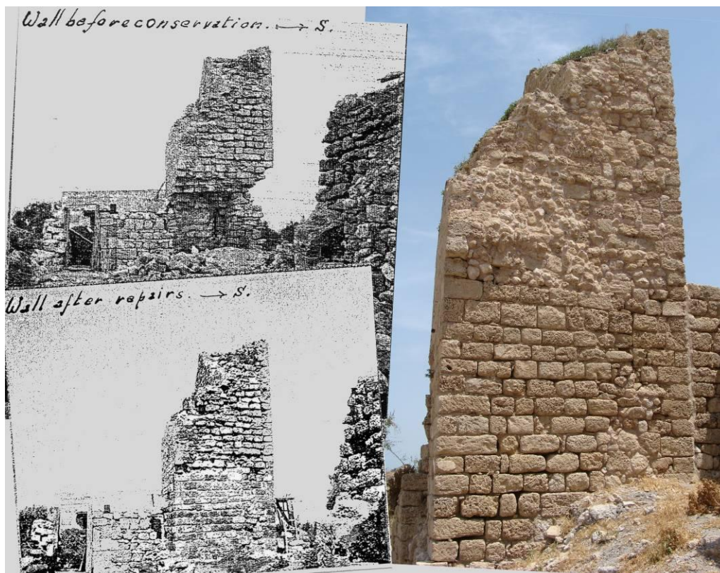
Figure 115 : Vue de la face Sud avant et après les restaurations des années 1920 (à gauche) et de nos jours (à droite)
