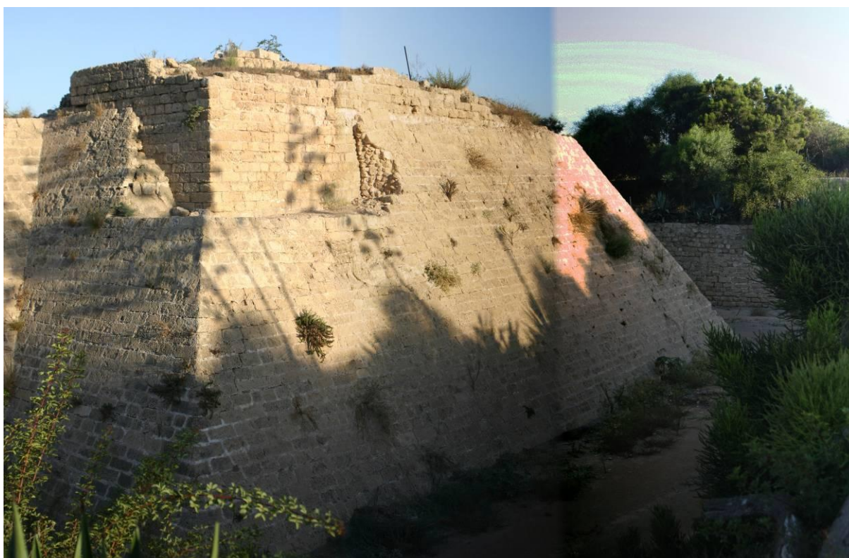
Figure 40 : Vue de la tour T3 prise depuis le Sud-Est
