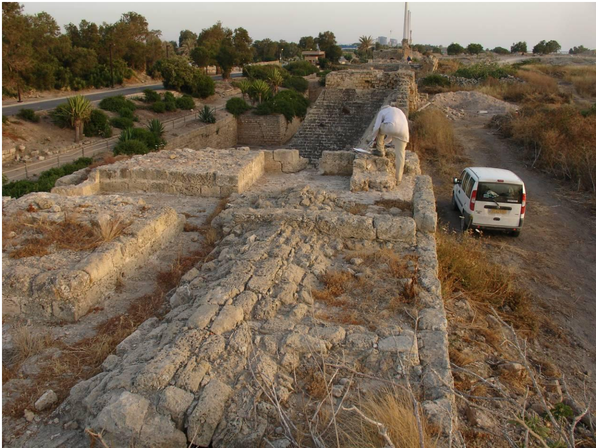
Figure 76 : Vue de la terrasse de la tour T5 prise depuis le Nord. On reconnaît au premier plan la voûte construite à l'époque bosniaque.
