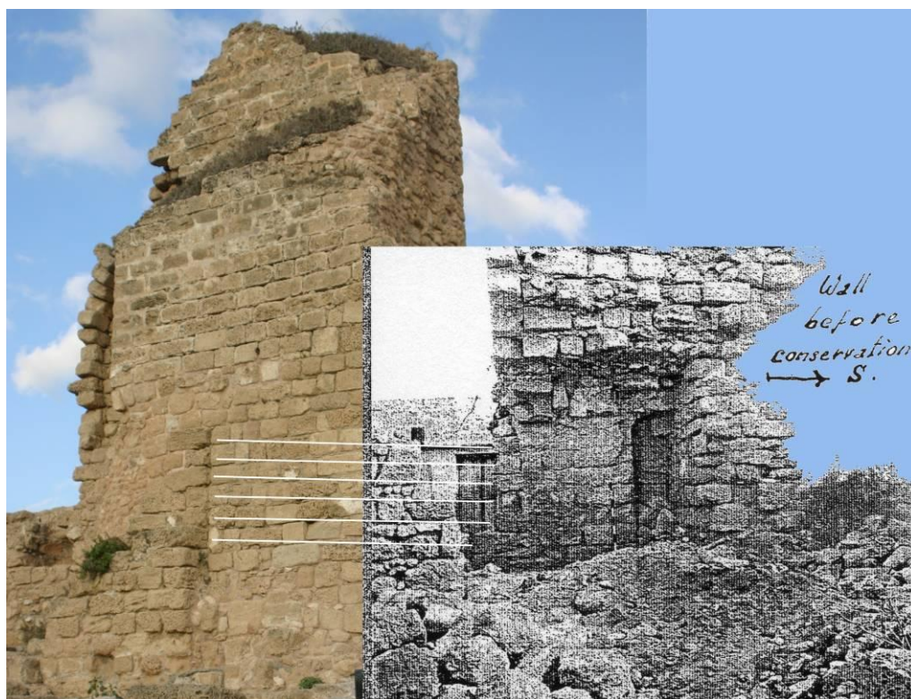
Figure 116 : Mise en correspondance de l'état actuel (à gauche, face Ouest du massif) et de l'état avant restaurations (à droite, face Sud du même massif). L'ancien parement Sud placé sous le surplomb (à droite), n'est plus reconnaissable aujourd'hui que par la harpe visible à gauche. Les flèches donnent la correspondance entre les pierres.
