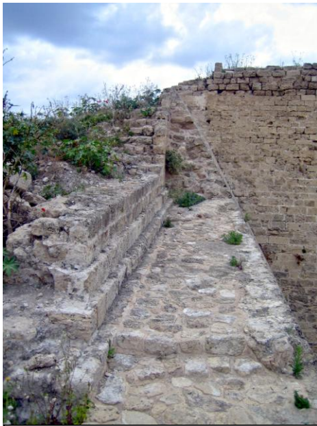
Figure 35 : Vue de la courtine 2-3 prise depuis l'Est, en position sur le glacis tronqué. Au fond, la tour T2
