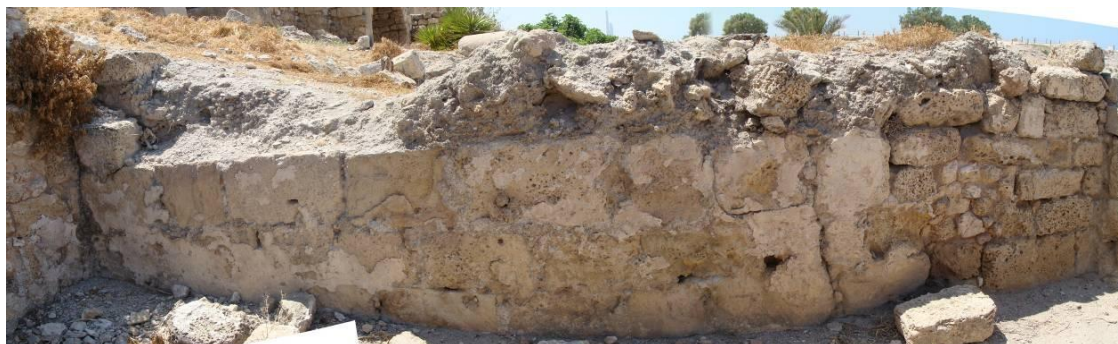
Figure 118 : Vue du mur M21 prise depuis le Nord, montrant le raccord entre les appareils de deux époques différentes
