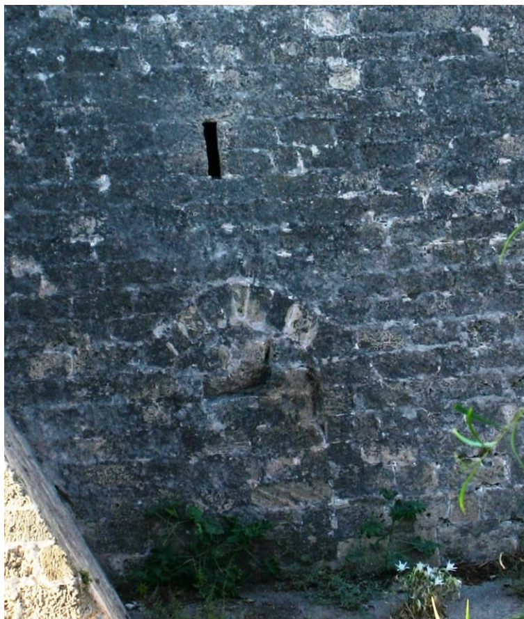
Figure 36 : Vue de la poterne P3 murée prise depuis le Nord
