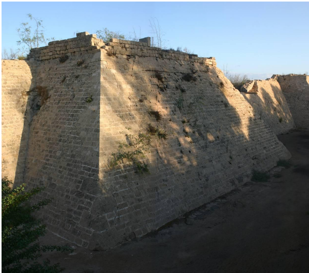
Figure 94 : Vue de la tour T7 prise du Sud-Est
