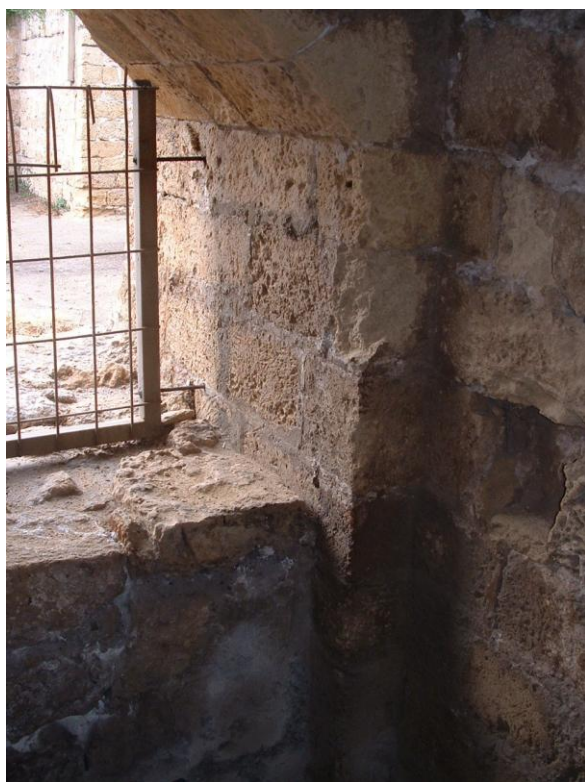
Figure 110 : Vue intérieure du piédroit Sud de la poterne. Noter le trou barrier.
