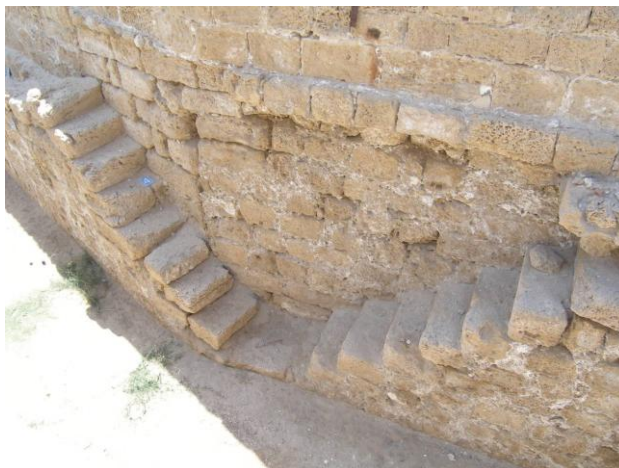
Figure 240 : Vue des escaliers prise depuis le Nord. A gauche, l'escalier Sud-Est, et derrière lui le remplissage de maçonnerie dans le vide du mur primitif
