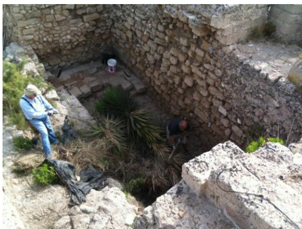
Figure 147 : Vue intérieure de la tour en 2010, prise pendant le déagrement de la végétation, depuis le Sud-Ouest. Noter en haut le pavage 1001
