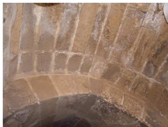
Figure 186 : Le raccord entre la voûte de la descente et celle de la sallette, vu depuis le Sud
