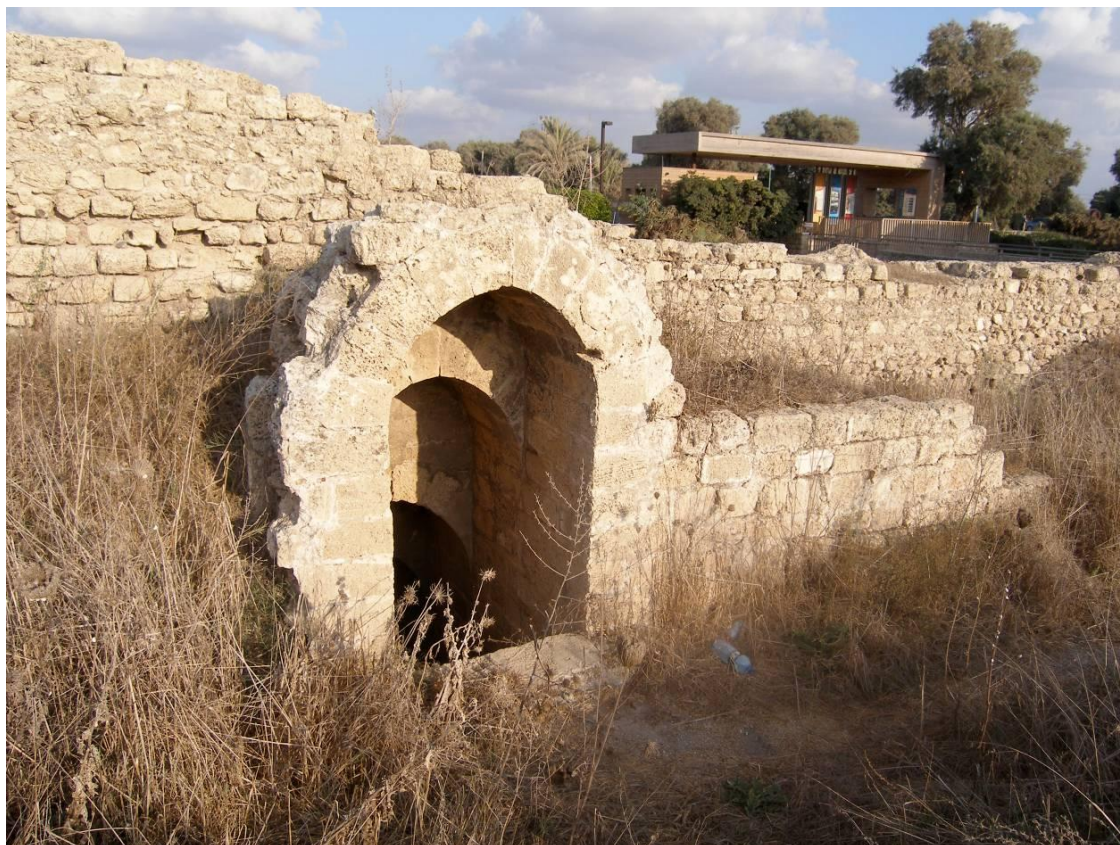
Figure 106 : Vue intérieure de la poterne, prise depuis le Nord-Ouest
