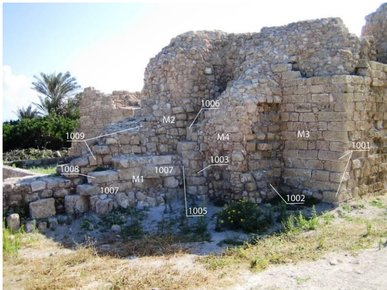
Figure 17 : Vue de l'angle Sud-Ouest de la tour 1 et du raccord avec la courtine T0-T1
