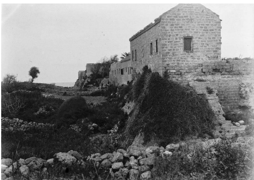
Figure 180 : Vue de la tour 12 prise du Sud-Est au début du 20e siècle
