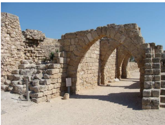
Figure 145 : Vue de l'arrière de la tour et des arcades sur rue, prise depuis le Nord-Ouest
