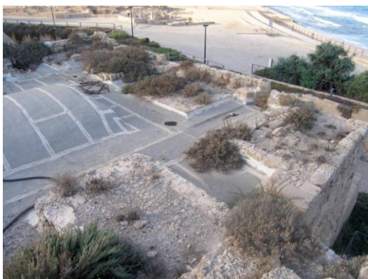
Figure 226 : Vue du dessus de la tour T15, prise depuis l'Ouest
