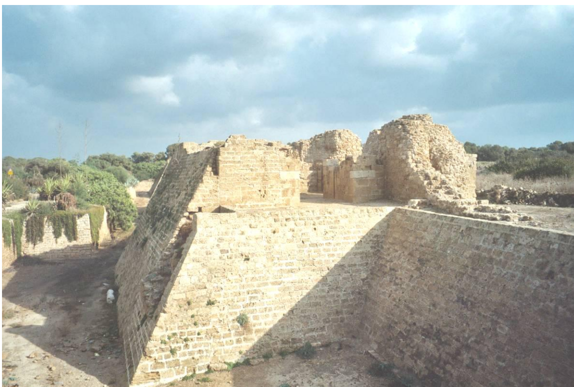
Figure 12 : Tour 1, vue depuis l'Ouest
