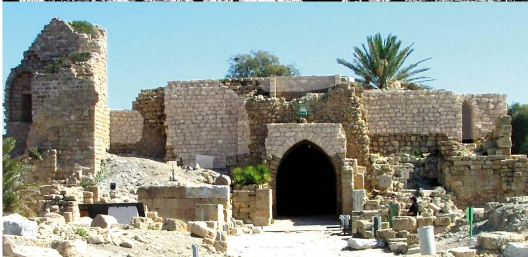
Figure 123 : Vue de la face arrière de la tour prise de l'Ouest. En haut, photographie de Negev prise pendant les travaux de dégagement. En-dessous, vue actuelle, avec tramage des parties reconstruites par Negev
