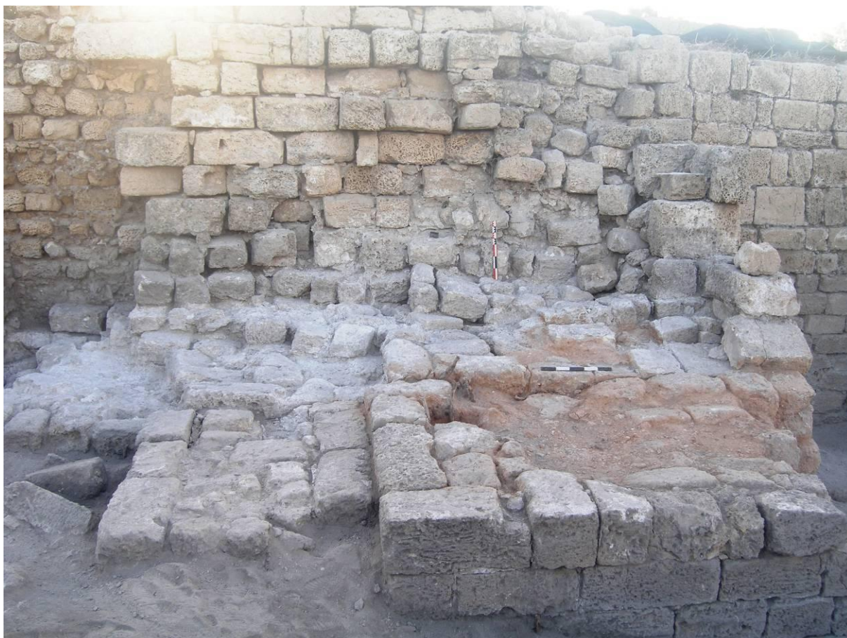
Figure 84 : Vue du raccord entre la courtine 5-6 et la tour 6, prise depuis l'Ouest. Au fond à gauche, épaississement de la courtine (Saint Louis). Au devant et au centre, courtine 5-6, avec son parement extérieur en élévation, sur lequel s'est collé le mur Saint Louis ; au devant encore, l'arase de la courtine primitive. Au premier plan à droite, angle Nord-Ouest du mur de gorge de deuxième phase, et à gauche mur d'époque inconnue ajouté. Enfin, au fond à droite, mur Est intérieur de la tour.
