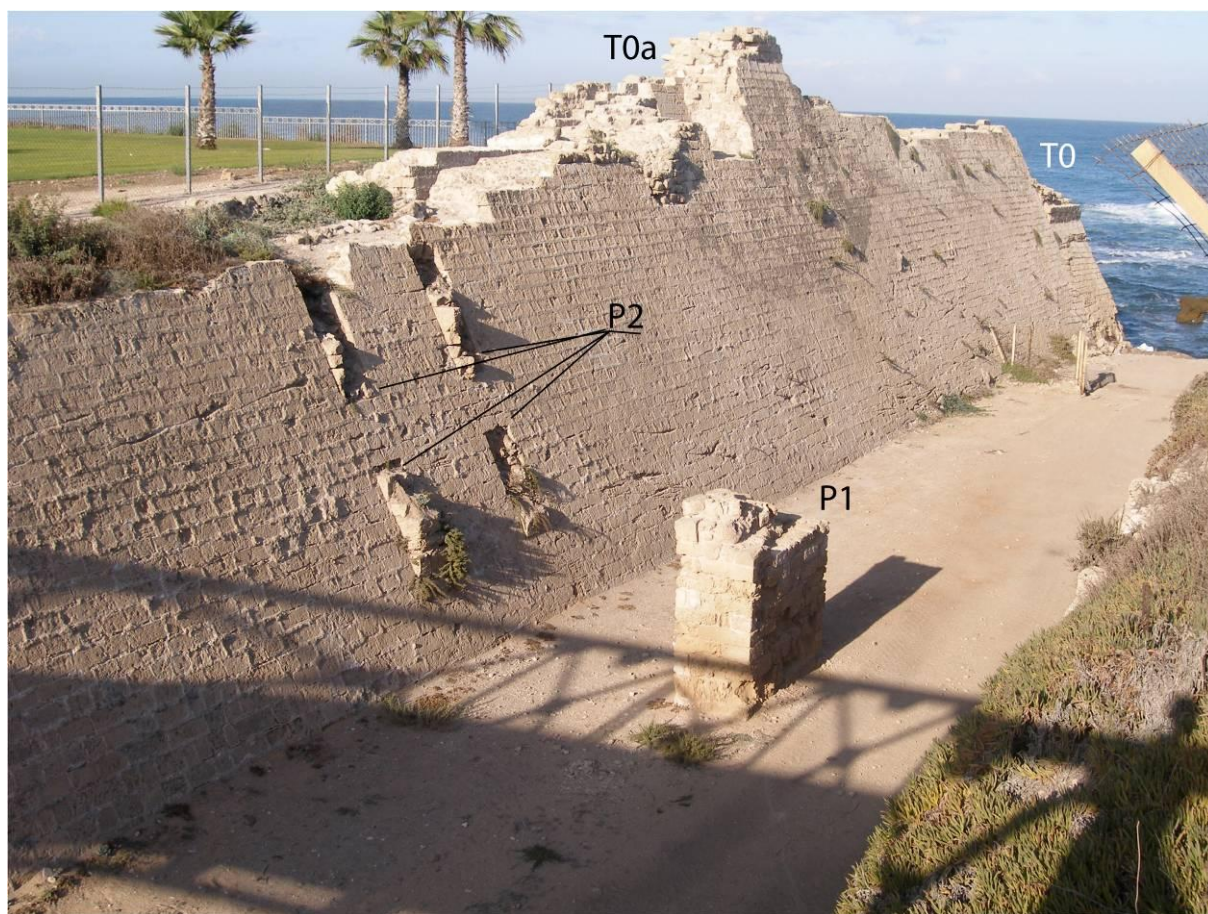
Figure 9 : Vue de la courtine 0-1 prise depuis le Nord-Est
