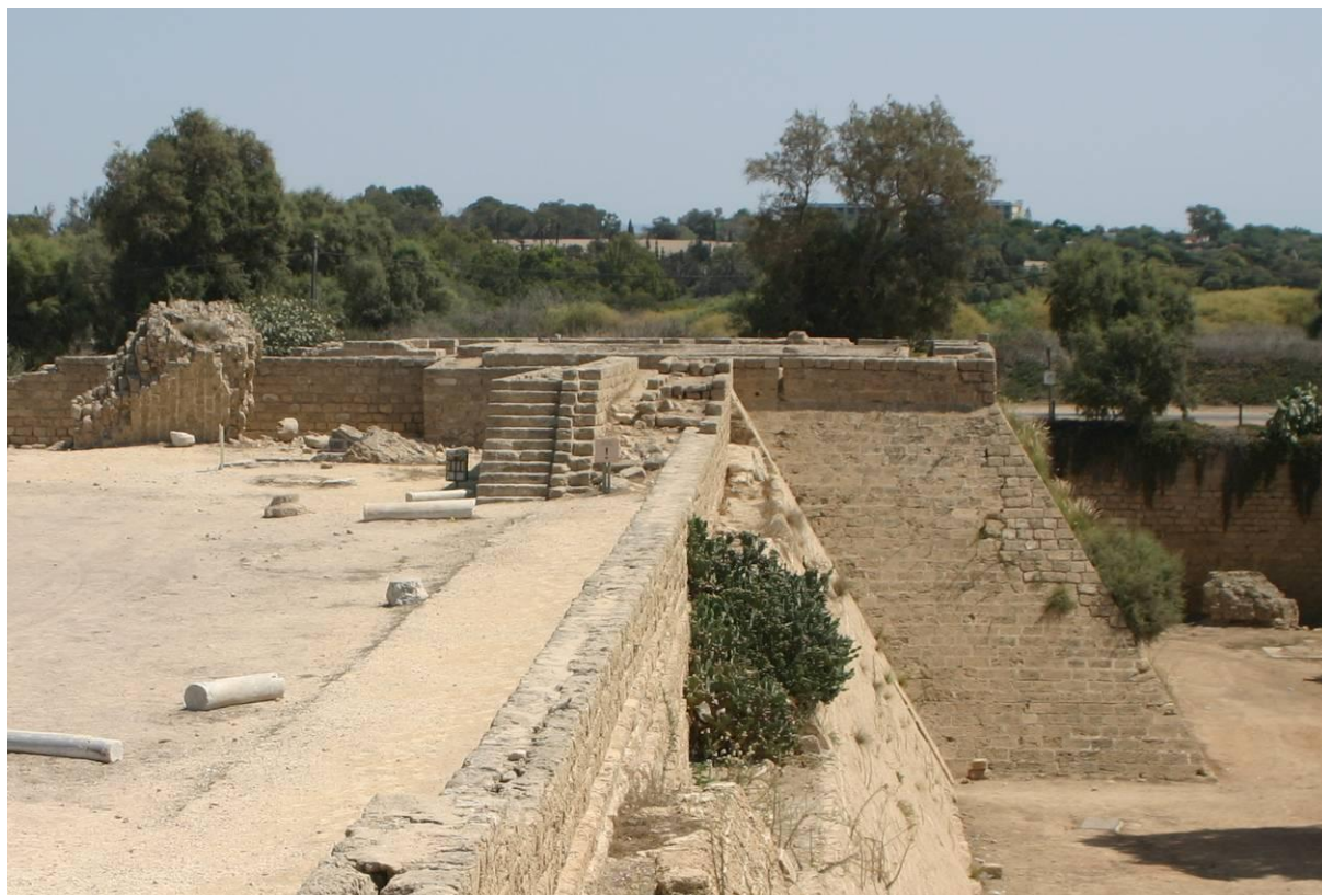
Figure 175 : Vue de la tour T12 prise de l'Ouest, devant la courtine 12-13. On voit à gauche de la tour l'escalier du massif supportant la coursive extérieure ; il est bordé par le parement Nord de la courtine restituée, puis on voit l'étroite galerie de circulation, et sur la droite le reste du mur de courtine. A gauche, devant la courtine, gros bloc provenant de la tour.
