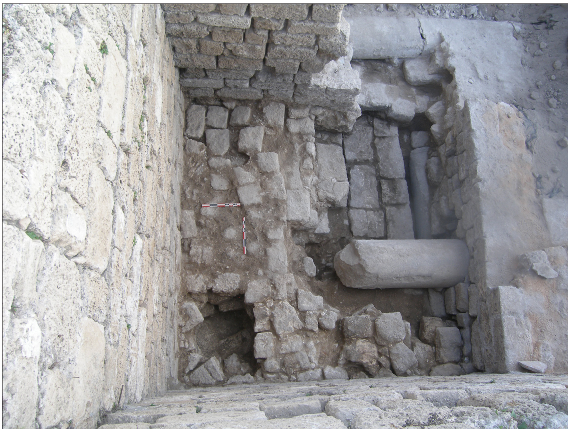
Cl.11 : Tour 6, vue générale du soubassement et des élévations internes de la tour 6. (Jocelyn Martineau 2010).
