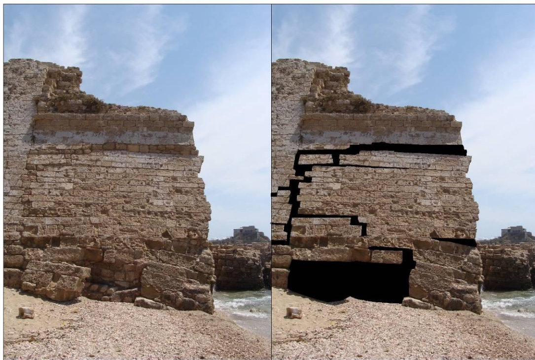
Figure 3 : Vue de la tour T0 prise depuis le Nord (2010)
