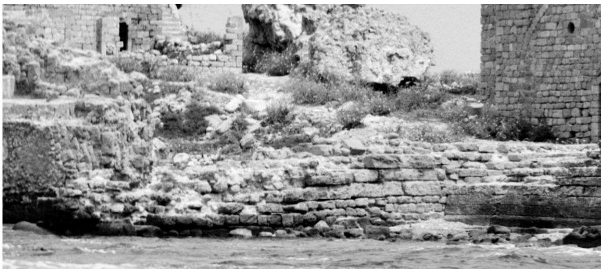
Figure 237 : Détail d'une vue de 1938 prise du Sud-Est, avec l'angle entre la courtine et le mur de contrescarpe du château. De gauche à droite : le grand bloc de maçonnerie du château tombé dans le fossé, puis les ruines du mur de contrescarpe avec leur fondation sur colonnes. Enfin, à droite, au-dessous du bâtiment bosniaque, premières assises de la courtine 15-16 (coll. Matson, Library of Congress).
