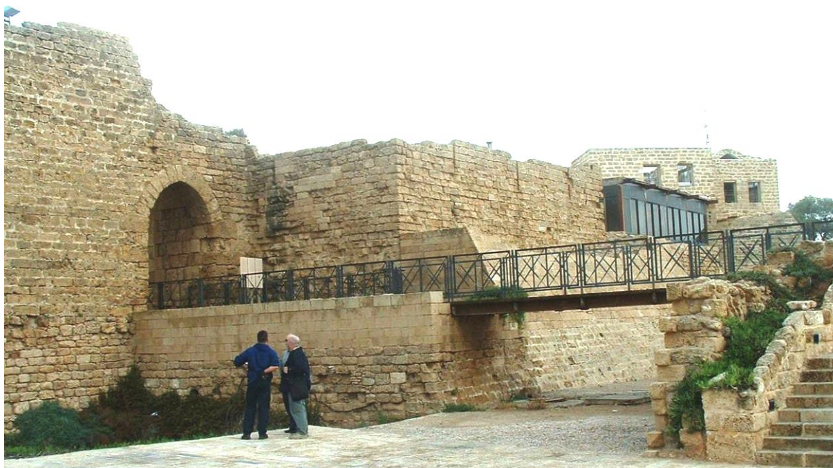
Figure 222 : Vue du secteur depuis le Sud-Ouest. De gauche à droite, la porte, puis la tour T15, et la courtine 15-14
