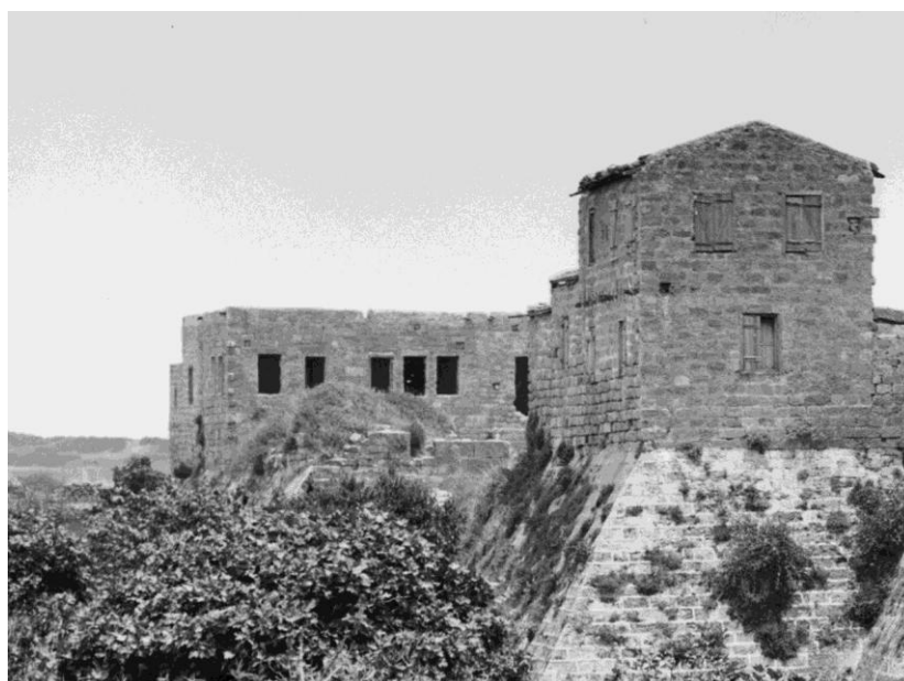
Figure 58 : La tour 1 vue depuis l'Ouest en 1938 (coll.Matson, extrait). On distingue, en avant du grand bâtiment de ferme moderne, le sommet de la face Ouest de la tour Ouest.
