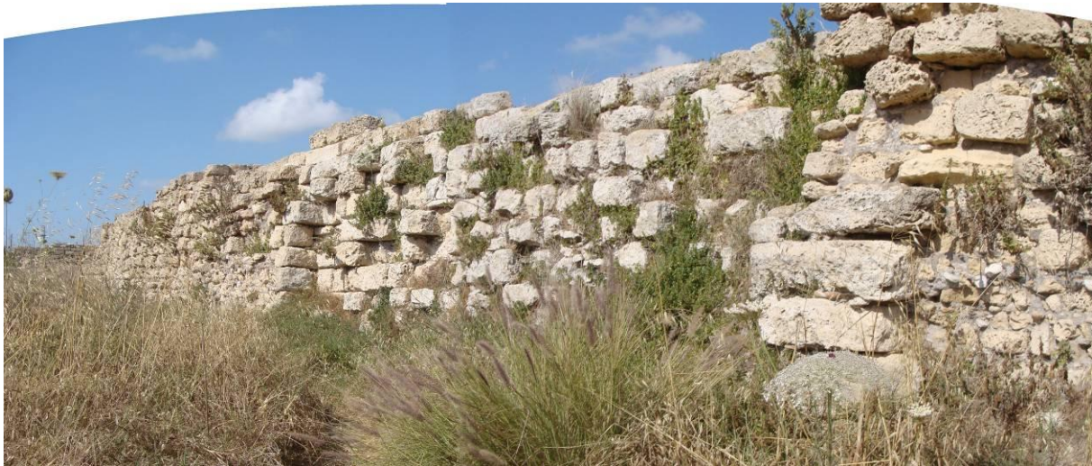
Figure 102 : Vue de la face Ouest de la tour T8, prise du Sud-Ouest
