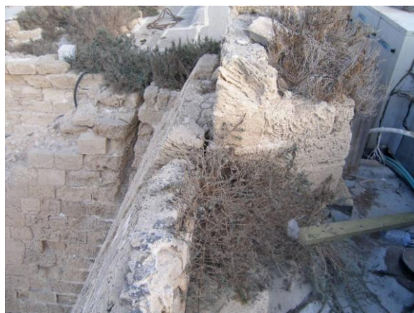
Figure 217 : Vue de l'angle entre la courtine 15 et la tour T15, prise depuis la courtine à l'Est de cet angle
