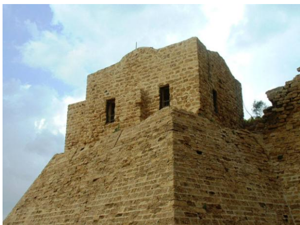
Figure 212 : Vue de la tour 14 prise depuis le Sud-Est
