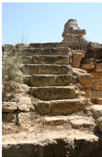
Figure 211 : Vue de l'escalier menant de la tour T14 au chemin de ronde de la courtine 13-14, prise depuis l'Ouest
