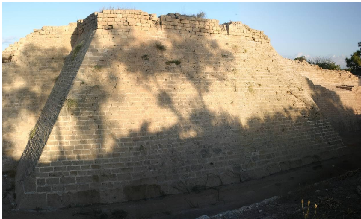
Figure 74 : Vue de la tour T5, prise du Sud-Est
