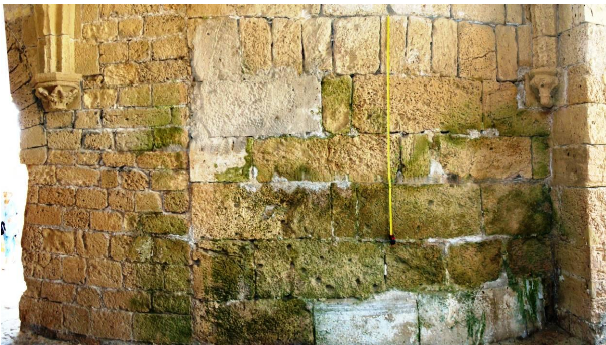
Figure 132 : Vue de la face intérieure Nord-Ouest, façade de la tour T9N
