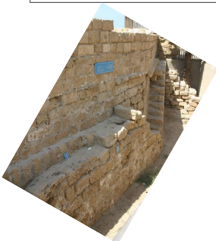
Figure 239 : Vue de la tranchée de fouille laissée à ciel ouvert, prise depuis le Sud-Est. De haut en bas, la maçonnerie Louis IX, puis la maçonnerie de la courtine primitive avec ses deux escaliers symétriques. On décèle au centre le remplissage de maçonnerie dans le vide de la courtine primitive, au revers de l'escalier.
