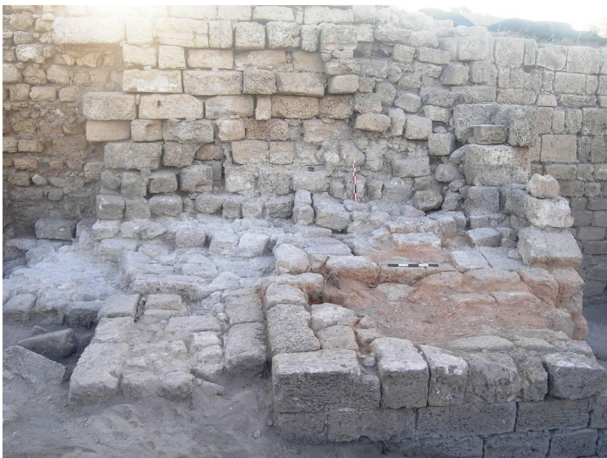
Figure 84 : Vue du raccord entre la courtine 5-6 et la tour 6, prise depuis l'Ouest. Au fond à gauche, épaississement de la courtine (Saint Louis). Au devant et au centre, courtine 5-6, avec son parement extérieur en élévation, sur lequel s'est collé le mur Saint Louis ; au devant encore, l'arase de la courtine primitive. Au premier plan à droite, angle Nord-Ouest du mur de gorge de deuxième phase, et à gauche mur d'époque inconnue ajouté. Enfin, au fond à droite, mur Est intérieur de la tour.
