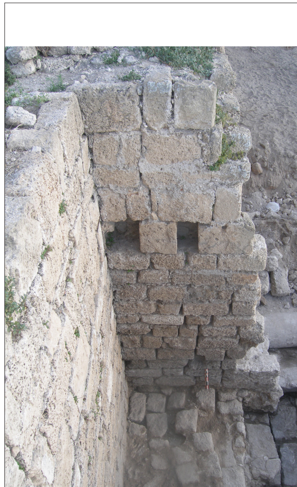
Cl.14 : Tour 6, vue du mur M20 vers le sud (Jocelyn Martineau 2010).
