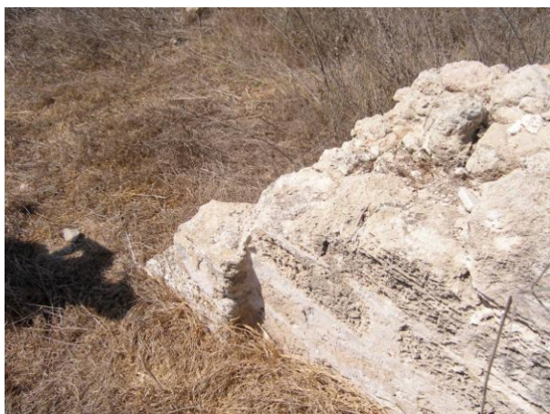
Figure 91 : La base du pilastre Nord de la courtine 6-7, vue depuis le NE
