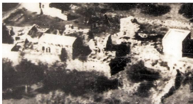
Figure 140 : Vue depuis le Nord-Est en 1938
