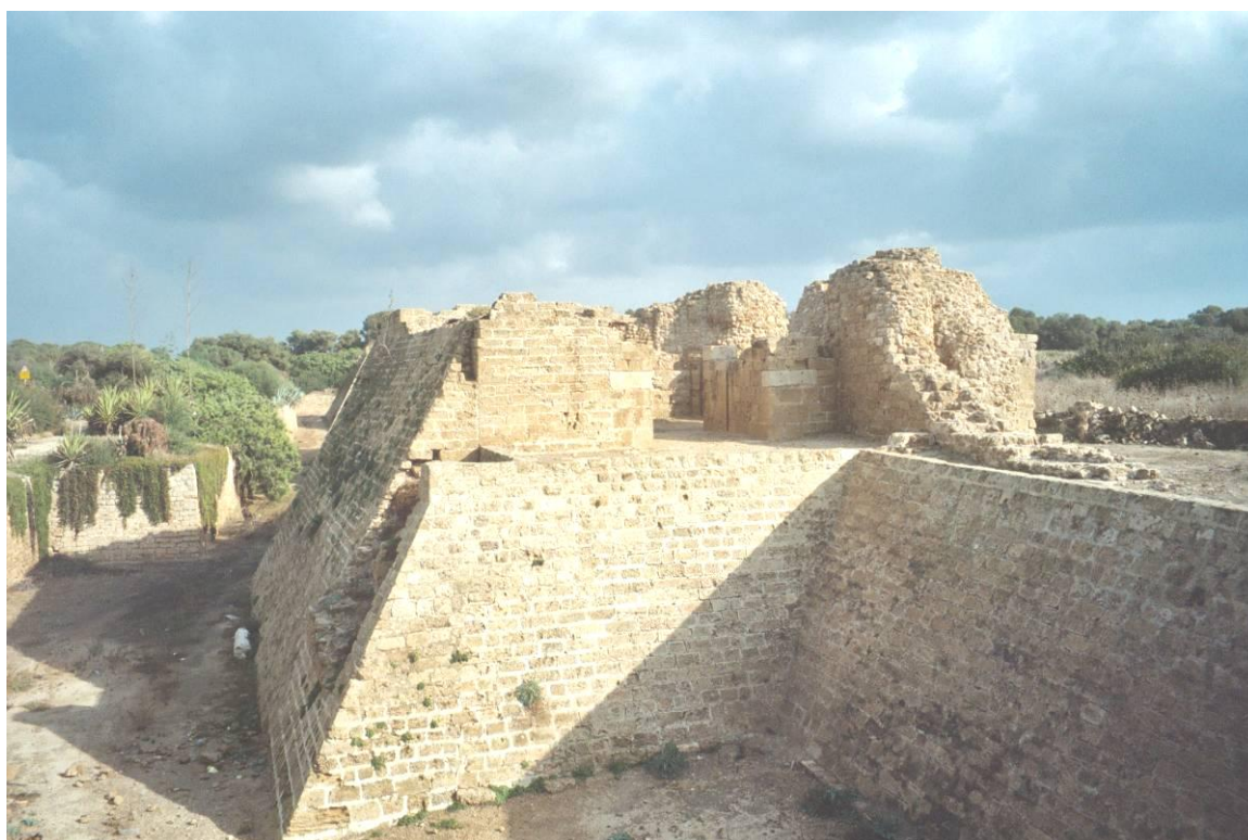
Figure 12 : Tour 1, vue depuis l'Ouest
