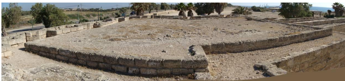
Figure 174 : Vue de la terrasse de la tour, prise au grand angle depuis le Nord
