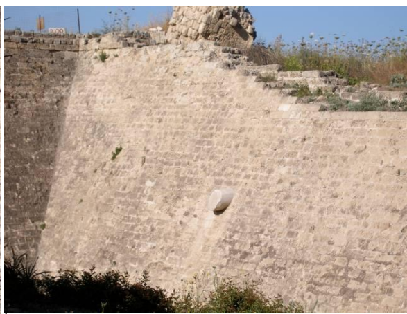
Figure 90 : Vue de la courtine 6-7 dans sa partie Sud, avec la colonne engagée dans le glacis
