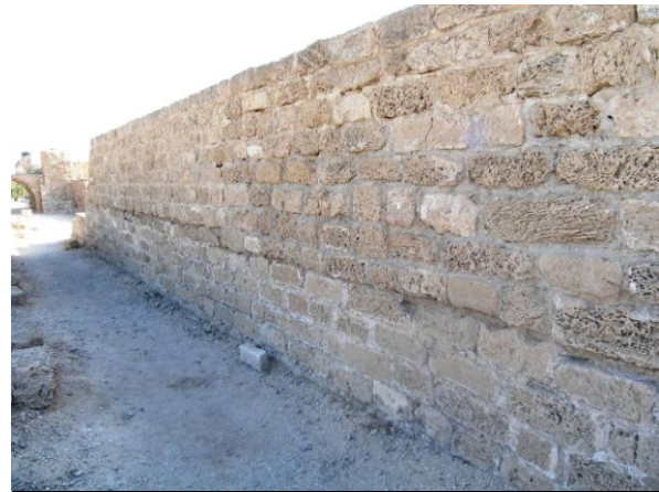
Figure 158 : Vue du massif d'accès à la tour collé à la courtine primitive à son revers, à l'Ouest, prise depuis le Sud-Ouest. Noter le bandeau marquant la limite de la restauration
