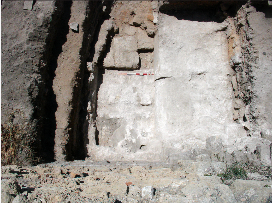
Cl.10 : Tour 6, vue de détail de la jonction entre la courtine sud et la tour, vers l'ouest. La base de la colonne byzantine est noyée dans un bain de mortier blanc encadré par deux colonnes couchées. (Jocelyn Martineau 2008).
