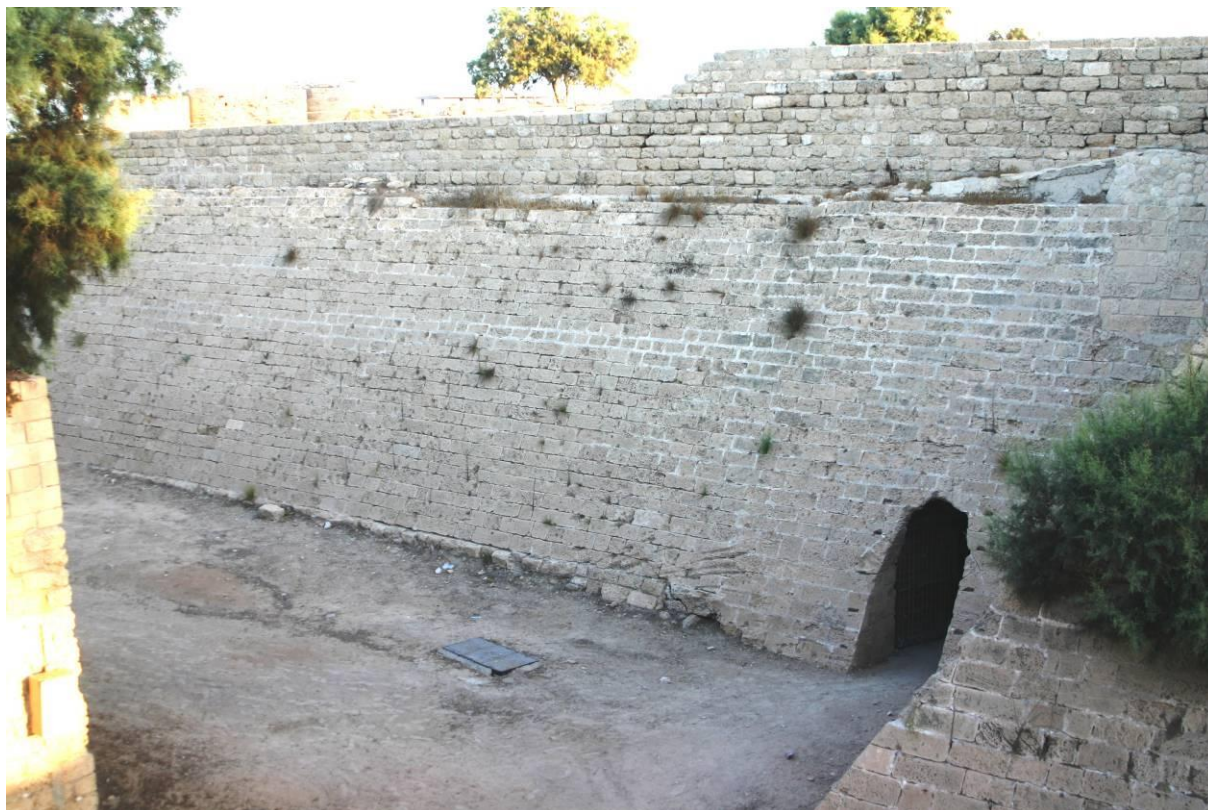
Figure 183 : Vue de la poterne P6 et de la courtine 12-13 depuis le Sud-Est
