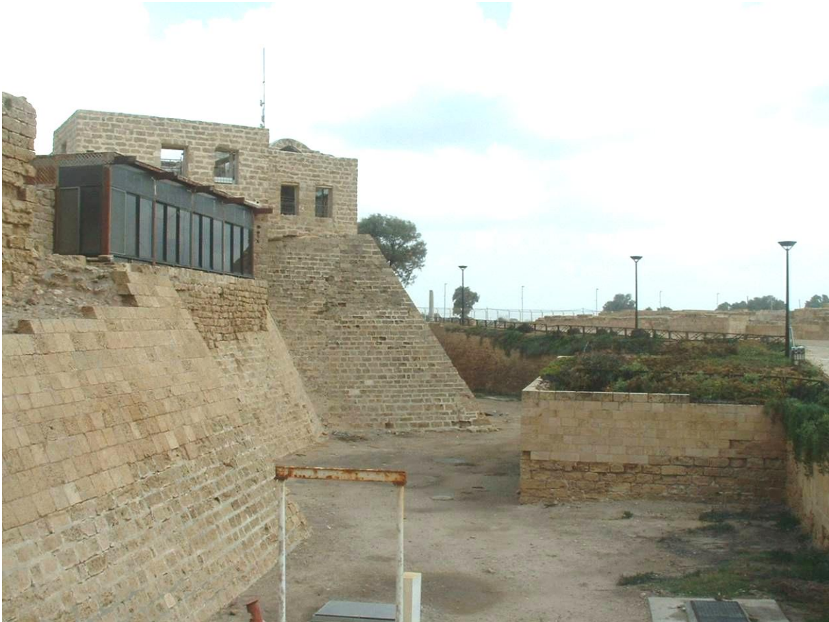
Figure 216 : Vue de la courtine 14-15 prise depuis l'Ouest
