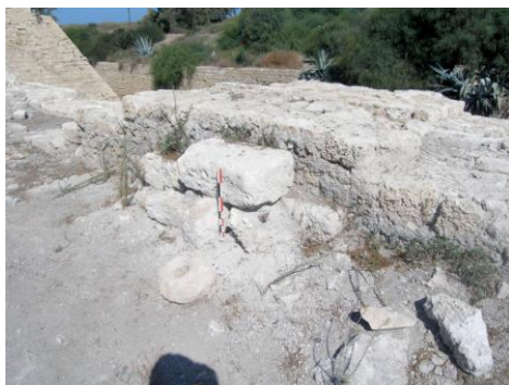
Figure 33 : Vue arrière du mur Est (Louis IX) avec les assises du parement d'une courtine disparue
