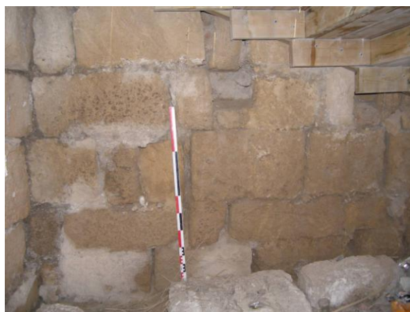
Figure 199 : Vue du parement Ouest de la salle de la tour primitive, prise en 2008 sous l'escalier de bois
