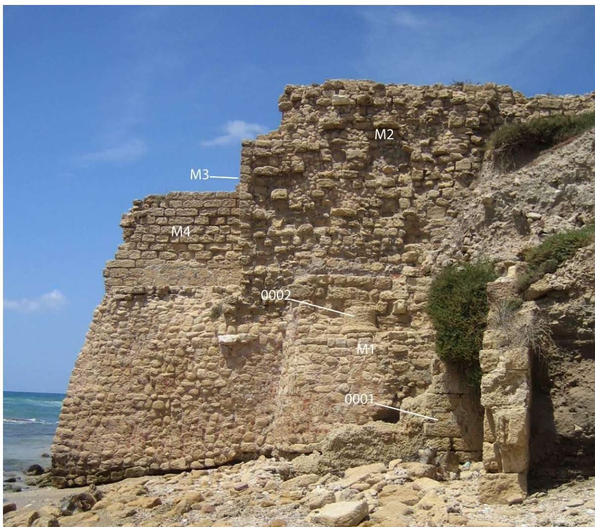
Figure 4 : Vue de la tour T0 prise depuis le Sud (2010)
