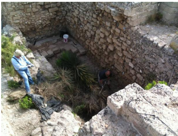
Figure 147 : Vue intérieure de la tour en 2010, prise pendant le dégageant de la végétation, depuis le Sud-Ouest. Noter en haut le pavage 1001
