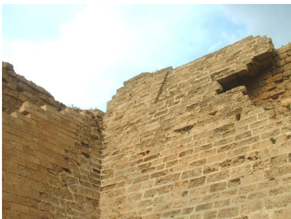
Figure 218 : Vue de l'angle entre la courtine 14-15 et la tour T15, prise depuis le fossé au Sud-Est
