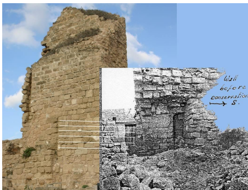
Figure 116 : Mise en correspondance de l'état actuel (à gauche, face Ouest du massif) et de l'état avant restaurations (à droite, face Sud du même massif). L'ancien parement Sud placé sous le surplomb (à droite), n'est plus reconnaissable aujourd'hui que par la harpe visible à gauche. Les flèches donnent la correspondance entre les pierres.
