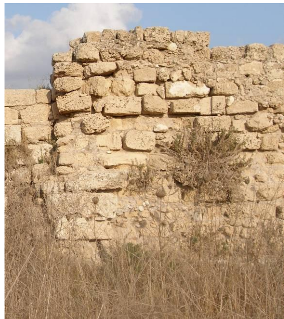
Figure 104 : Le raccord Sud entre le contrefort (à gauche) et la maçonnerie Saint Louis (à droite). Le parement Est des angles du contrefort est conservé devant la maçonnerie Saint Louis
