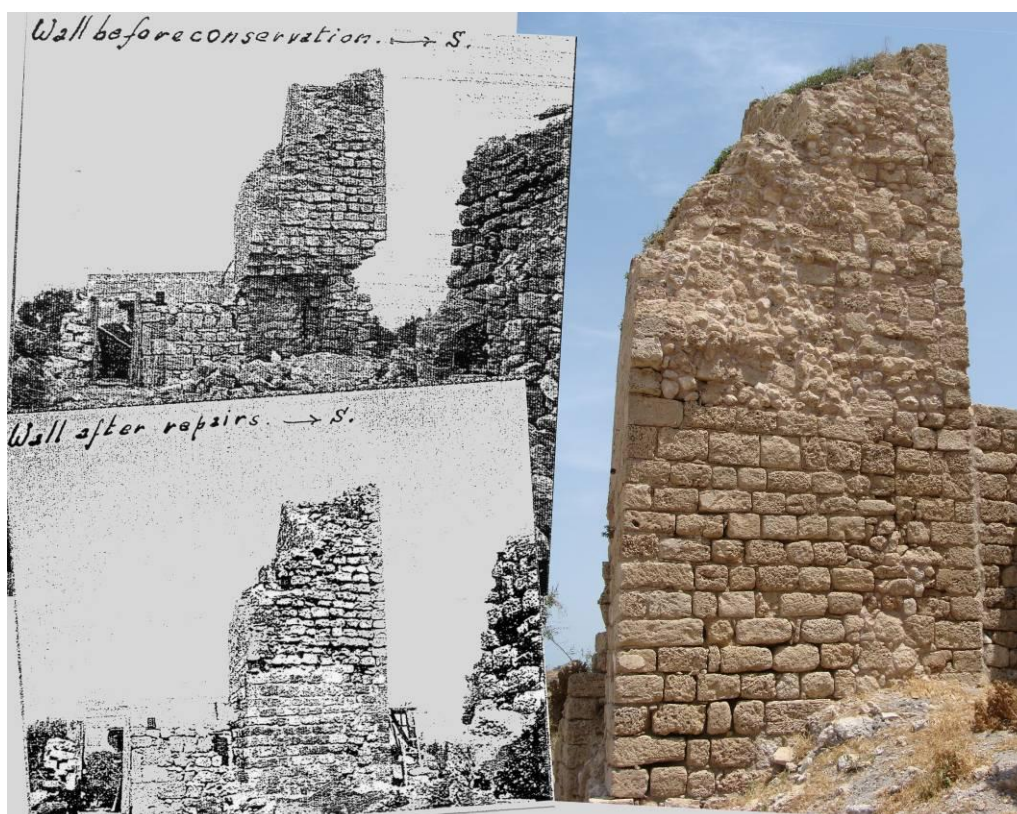
Figure 115 : Vue de la face Sud avant et après les restaurations des années 1920 (à gauche) et de nos jours (à droite)
