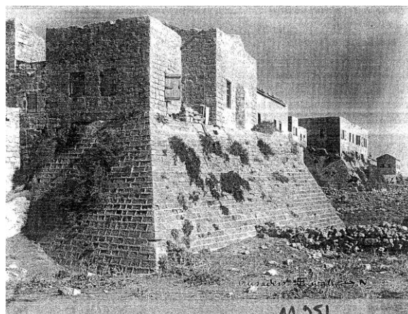
Figure 213 : Vue de la tour T14 prise depuis le Sud-Ouest dans les années 1920
