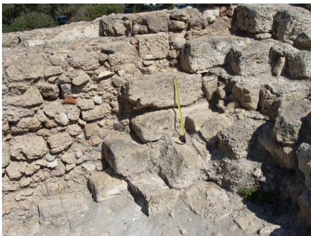
Figure 161 : Vue de détail du parement Nord de la courtine primitive, pris depuis le Sud.
