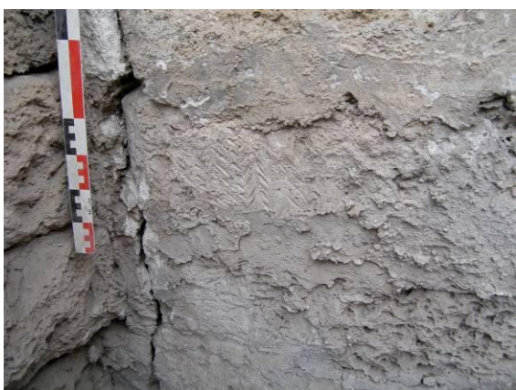
Figure 65 : Vue du raccord Nord-Ouest entre le mur Louis IX Nord et le mur primitif (à gauche). On distingue les traces d'enduit sur la maçonnerie Louis IX
