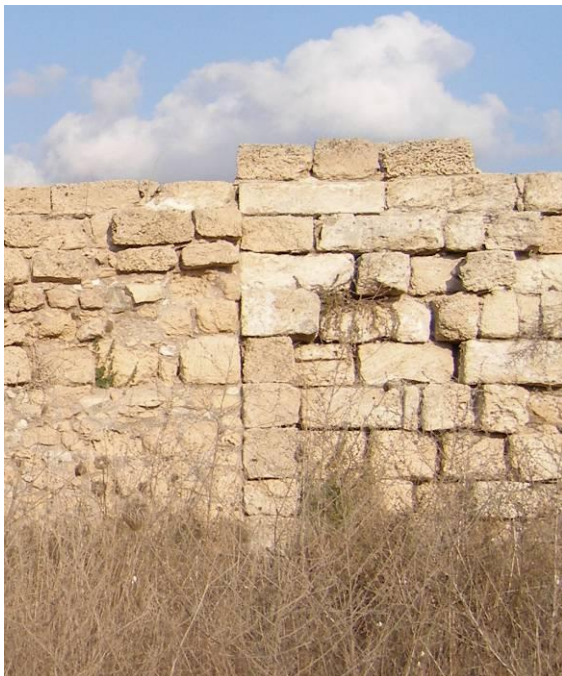
Figure 103 : Le coup de sabre Nord, marquant le raccord entre l'épaississement Saint Louis (à gauche) et la maçonnerie du contrefort primitif (à droite)
