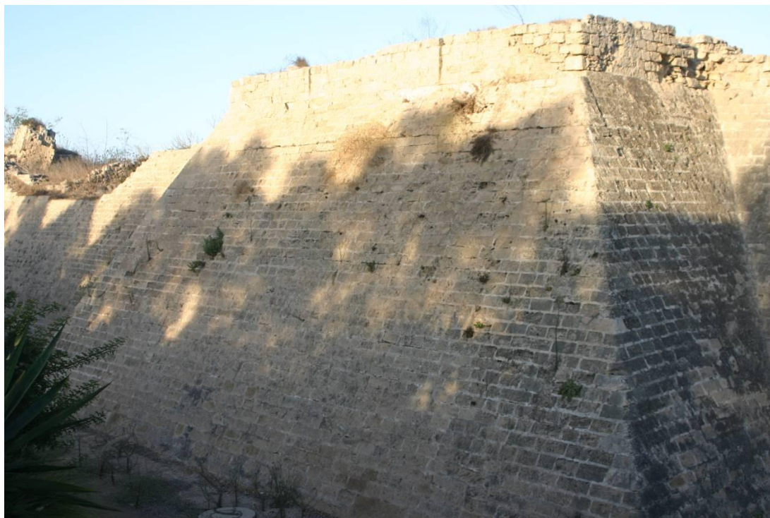
Figure 82 : Vue de la tour T6 prise du Nord-Est
