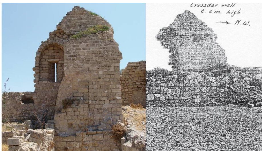
Figure 114 : Face Ouest. Comparaison entre l'état actuel et celui des années 1920
