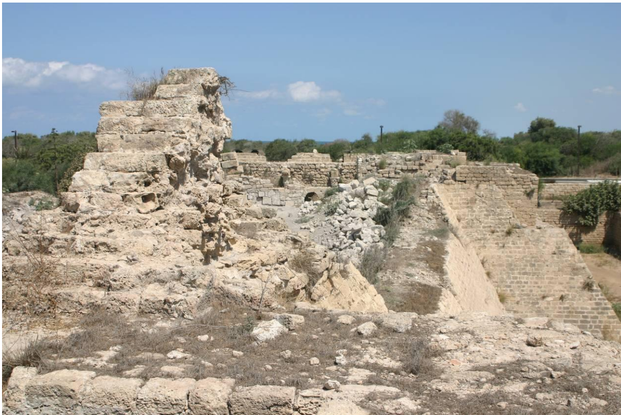
Figure 66 : Vue du moignon d'escalier de la courtine 3-4, pris depuis le Sud.
