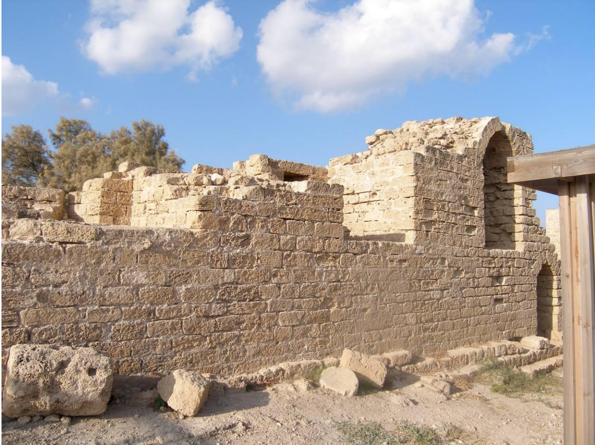
Figure 207 : Vue de la partie Est de la courtine 13-14, prise depuis le Nord-Est
