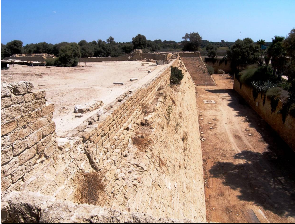
Figure 188 :Vue de la courtine 12-13 prise depuis l'Ouest
