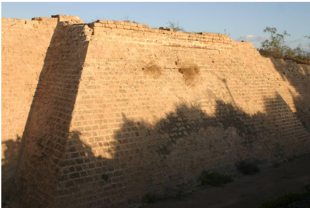
Figure 101 : Vue de la tour 8 prise depuis le Sud-Est
