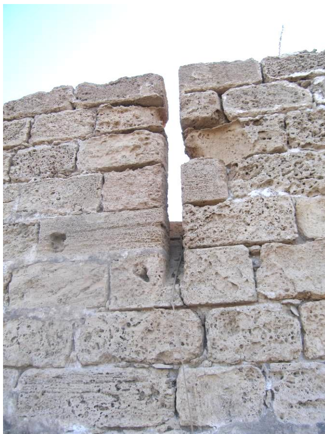
Figure 225 : Vue de dessous d'une fente d'archère de la tour T14. Les trois assises inférieures correspondent à la plongée.
