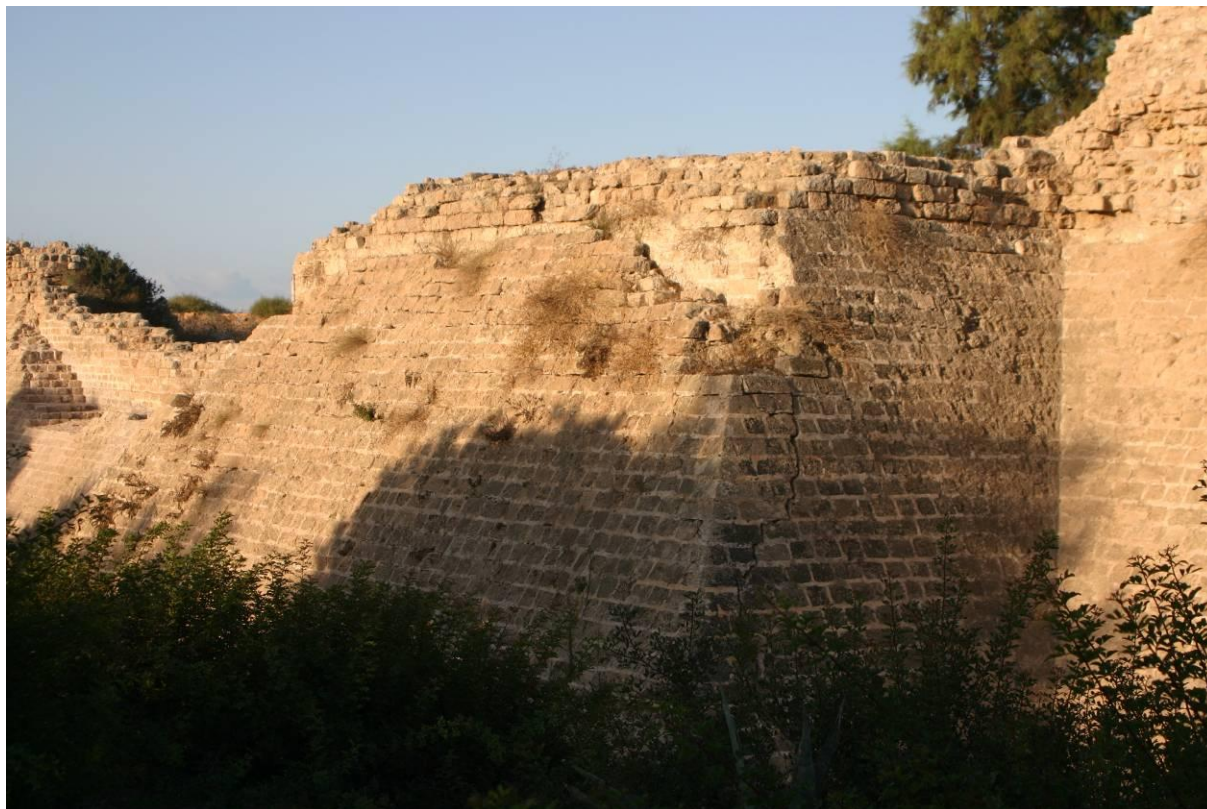
Figure 61 : Vue de la tour T4 depuis le Nord-Est en 2007
