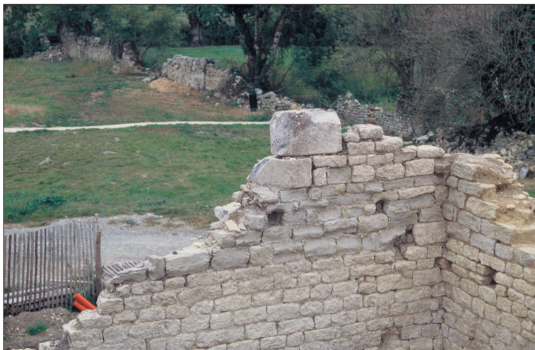
Photo 29 : vue des vestiges d'une fenêtre tournée vers le marais
