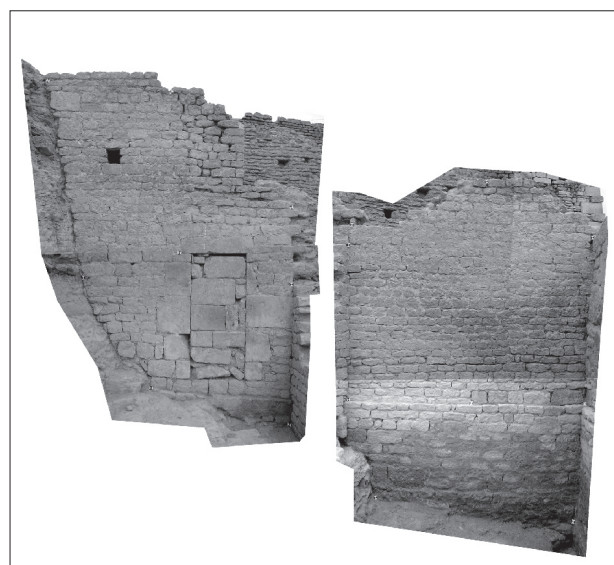
photo 36 : élévation intérieure du mur pignon est M6. La porte obturée 149 est située à gauche
