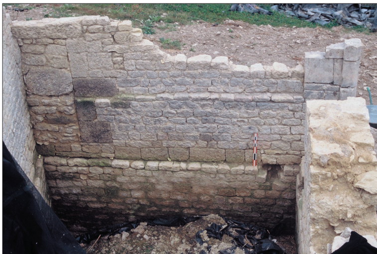
Photo 35 : vue du mur sud du conduit de latrines.
