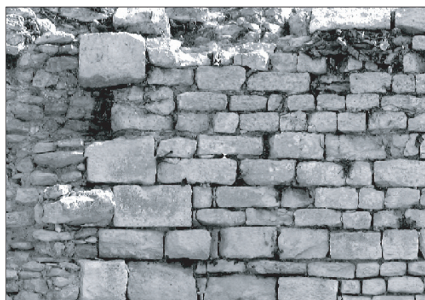
Photo 28 : parement du mur de façade M1
