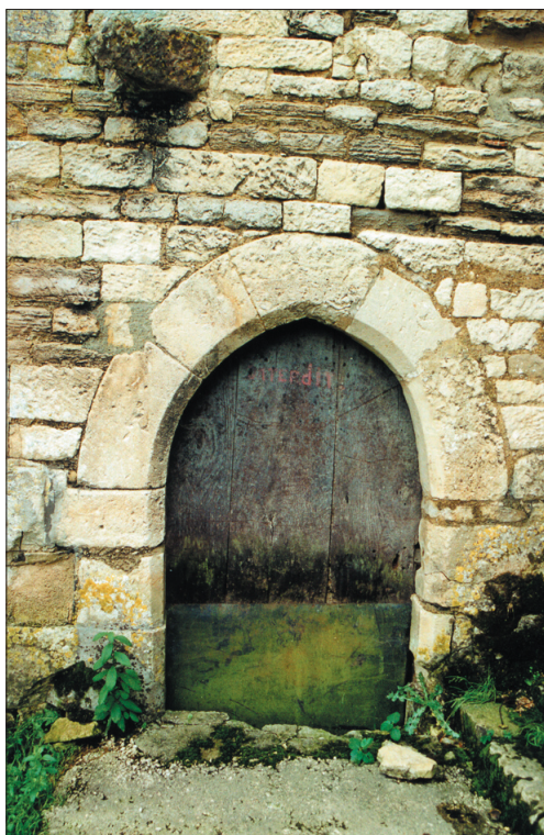
Photo 46 : porte avec arc ogival ouverte dans l'aile est de l'hôtellerie.
