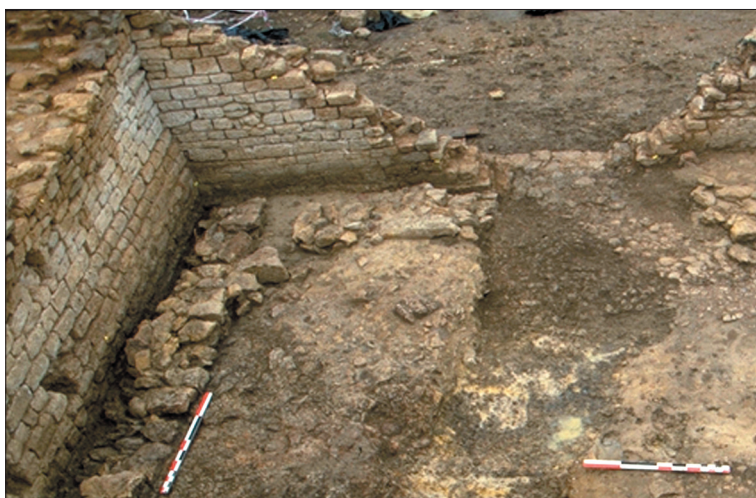
Photo 21 : vue des arases 228 à gauche et 222 à droite, au pied des murs M1 et M2
