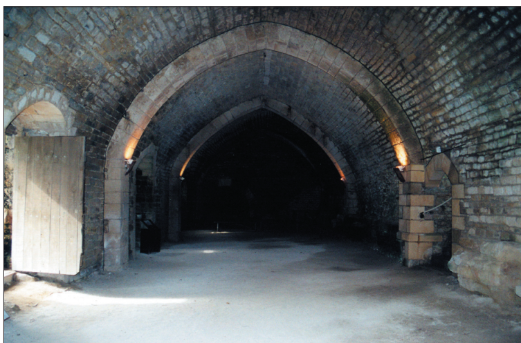
Photo 44 : vue générale du cellier de l'hôtellerie
