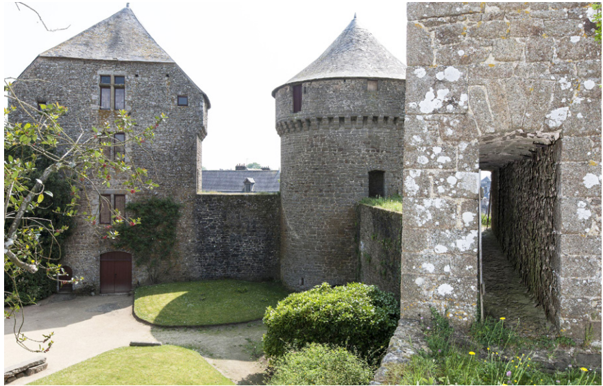
► Fig. 18 : vue au premier plan de la gaine de circulation aménagée à l'arrière de la gorge de la tour Lavoisier, dans la continuité du chemin de ronde du front sud. Vue en arrière-plan de la même gaine de circulation horizontale à l'arrière de la tour du Bûcher. © Yves Guillotin, Inventaire, Région des Pays de la Loire, 2019.
