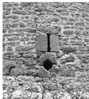
▲ Fig. 22 : vue de la canonnière en point d'exclamation ouverte en front d'attaque de la tour du Bûcher, en direction de la chapelle Notre-Dame-du-Rocher. © J.M., 2019.
