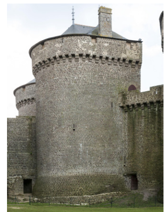
▼ Fig. 20 : vue des vestiges restaurés de la caponnière aménagée a posteriori contre le pied de la tour nord du châtelet, entre la poterne de l'enceinte polygonale à droite et la porte d'accès à la galerie basse du boulevard d'artillerie à gauche. © Yves Guillotin, Inventaire, Région des Pays de la Loire, 2019.
