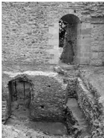
Figure 15 – Blain, sondage 5, vue de l'élévation interne de la courtine orientale et des accès à la demi-tour est (cl. P. Bellanger)
