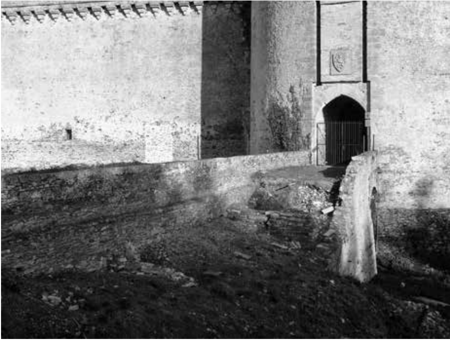
Figure 11 – Blain, vue des piles du xiv e siècle noyées dans le pont moderne (cl. P. Bellanger)
