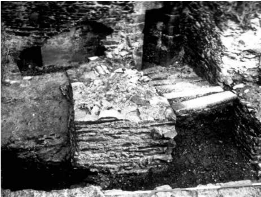
Figure 12 – Blain, vue des fondations des escaliers successifs de la tour des Prisons (cl. P. Bellanger)
