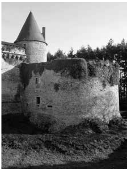
Figure 14 – Blain, vue de la tour sud-est (cl. P. Bellanger)
