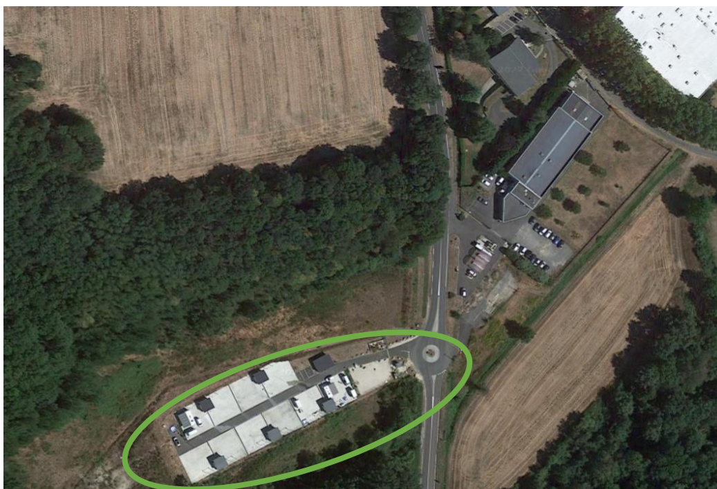
Figure 1 : Situation de l'aire d'accueil de Dourdan, département de l'Essonne (source : Google earth, 3 mars 2022)
