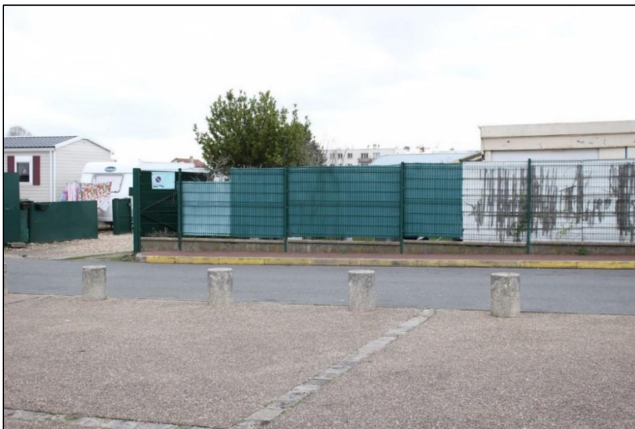
Figure 4 : L'entrée du terrain désigné de Morsang-Sur-Orge (en face de celui-ci, l'entrée du lycée professionnel) (A. Lecomte 2021)
