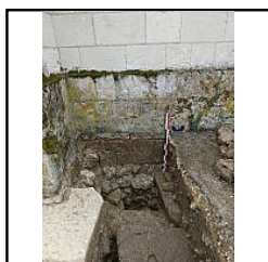
Photo 101 Mur M17, fondation/élévation - (Pioger Alexandre)
