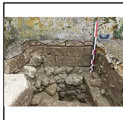
Photo 103 Mur M17, fondation/élévation - (Pioger Alexandre)
