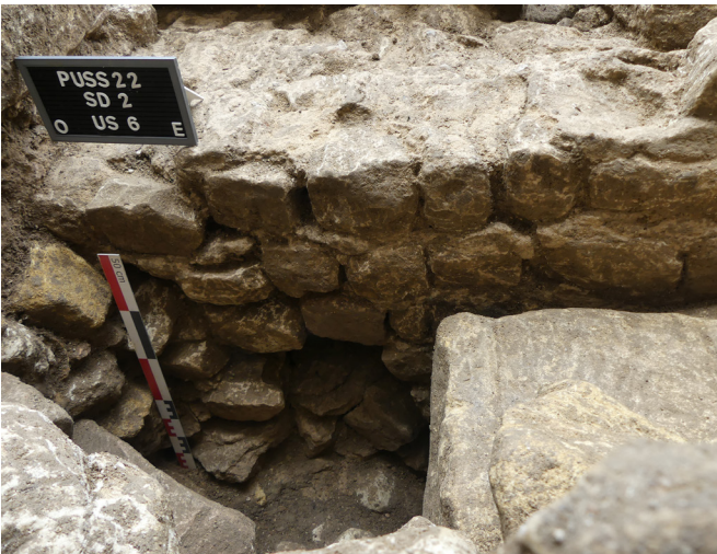
Figure 42 : Parement sud du mur M18, sondage 2
