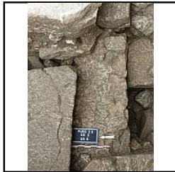
Photo 88 Détail mur M18, vue zénitale - (Pioger Alexandre)
