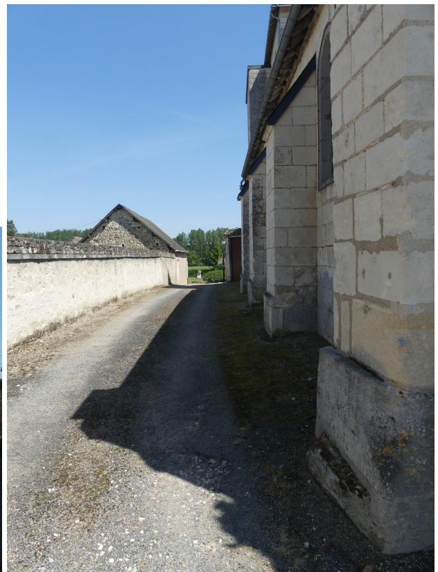
Figure 5 : Vue du Chemin du Port avant intervention
