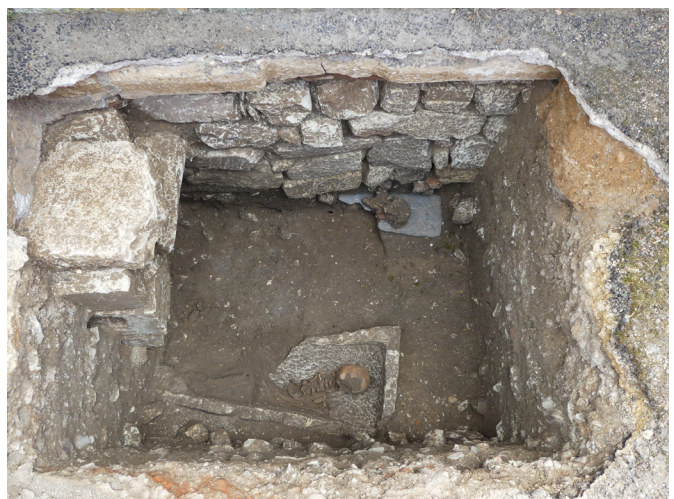
Figure 57 : Vue générale de l'apparition des vestiges funéraires du sondage 3, sous d'importants remblais 11-12 e s.
