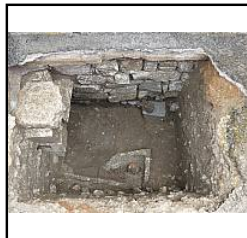
Photo 116 Vue générale du sondage 3 - (Silberstein Grégory)
