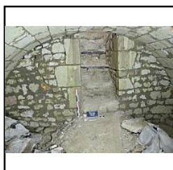
Photo 75 Mur ouest du caveau avec entrée - (Papin Pierre)
