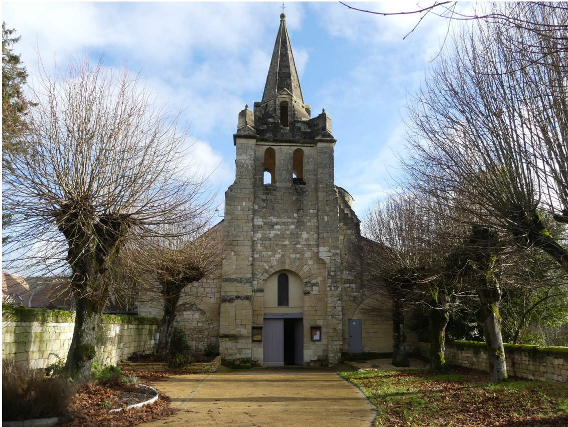
Figure 11 : Facade actuelle de l'église Saint-Pierre (ancien transept roman). A gauche et à droite du portail, les départs des anciens collatéraux bouchés.
