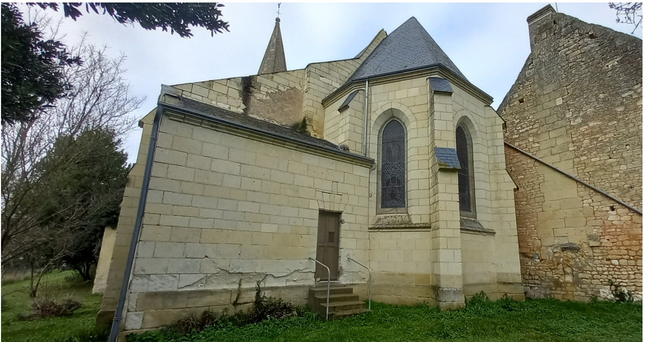
Figure 14 : Vue du chevet actuel de l'église Saint-Pierre, avec son choeur ajouté en 1850 (à droite) et la sacristie ajoutée durant la seconde moitié du 19 e s. (à gauche)
