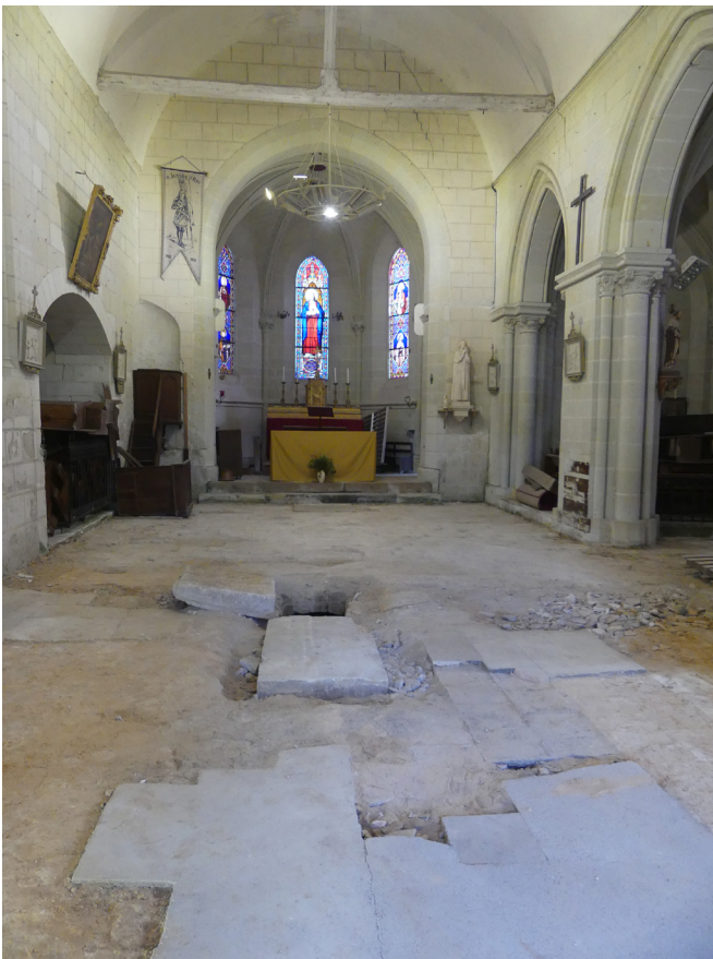
Figure 4 : Vue de l'intérieur de l'église de Seuilly après dépose du sol. Au premier plan, l'entrée du caveau découvert fortuitement en décembre 2022
