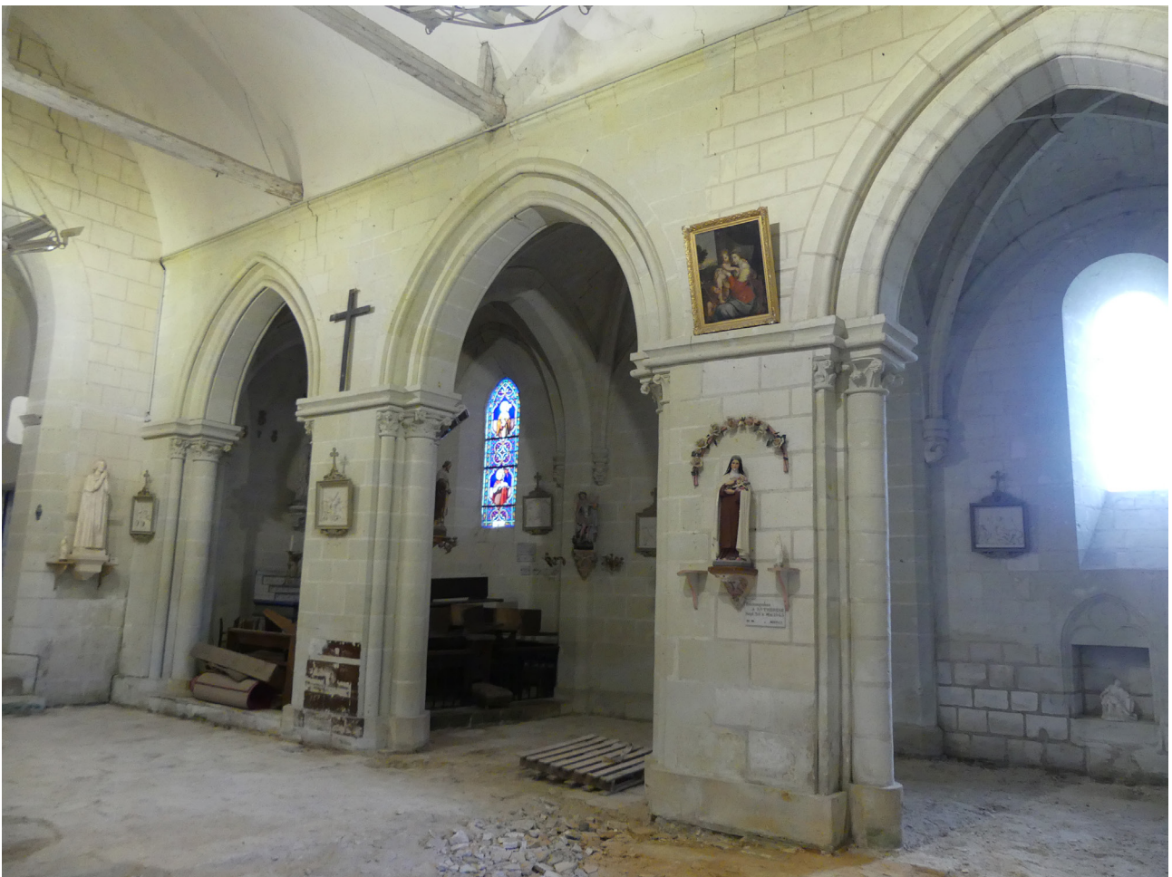
Figure 15 : Vue du collatéral ajouté durant la seconde moitié du 19 e s. depuis l'intérieur
