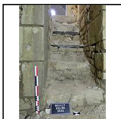
Photo 76 Détail escalier de l'entrée du caveau - (Papin Pierre)
