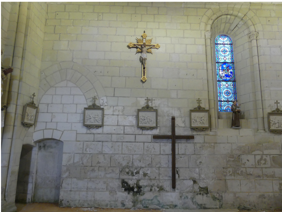
Figure 12 : Mur nord de l'église Saint-Pierre (ancien mur du chœur roman)
