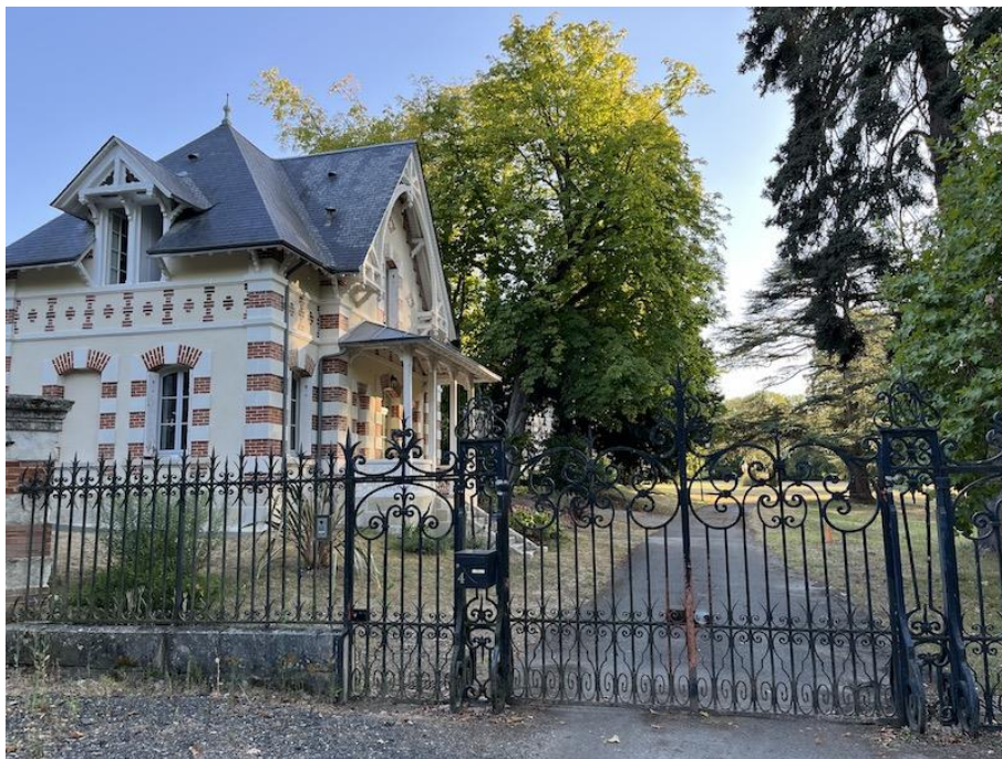
L'une des grilles d'entrée avec le pavillon du concierge aujourd'hui maison d'habitation privée, août 2022
