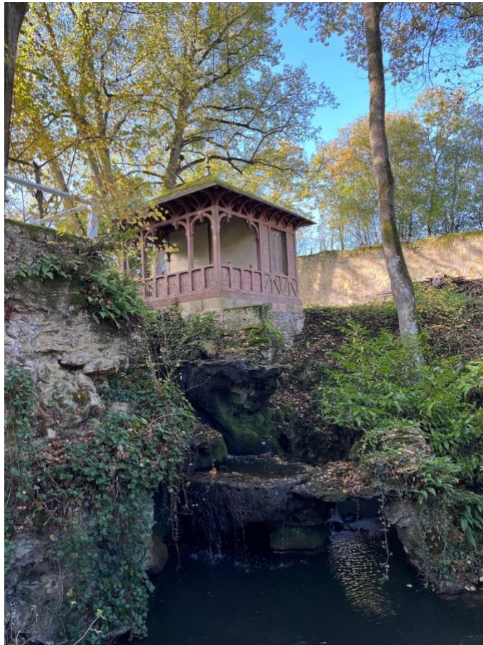
Le kiosque aujourd'hui, qui fait partie de la propriété voisine. Il y a juste un filet d'eau qui coule
