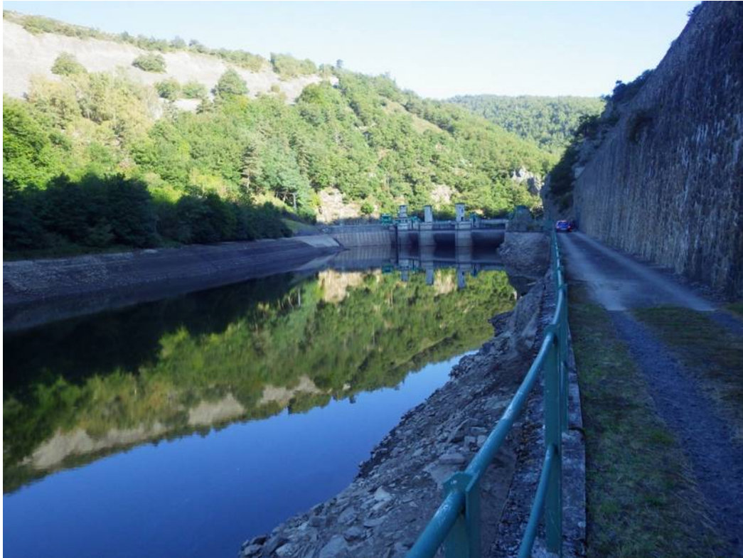
Secteur 3 : Partie aval retenue & barrage - 2014
