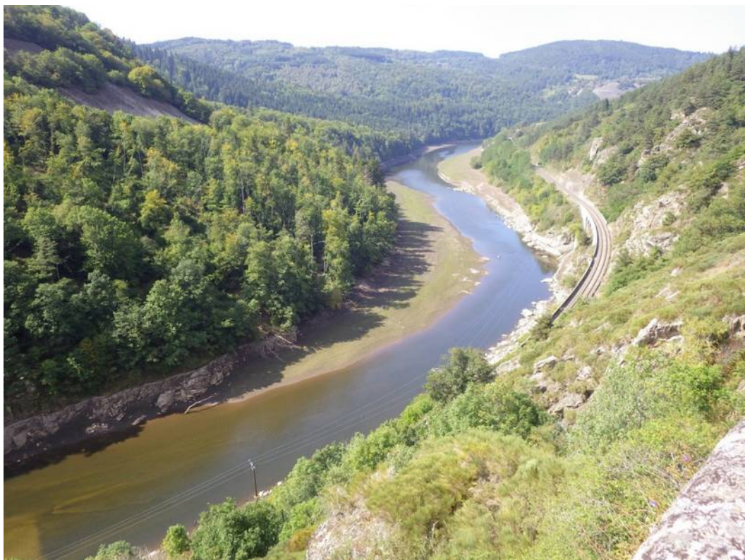
Secteur 3 : Retenue (partie intermédiaire) - 2014
