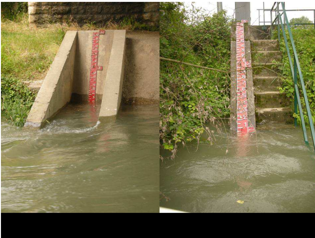
Figure 9 : Exemple de règle limnimétrique (pk38 à gauche, en rive droite sous le pont de Loyettes ; pk44.5 à droite, en rive gauche en face du CNPE).
