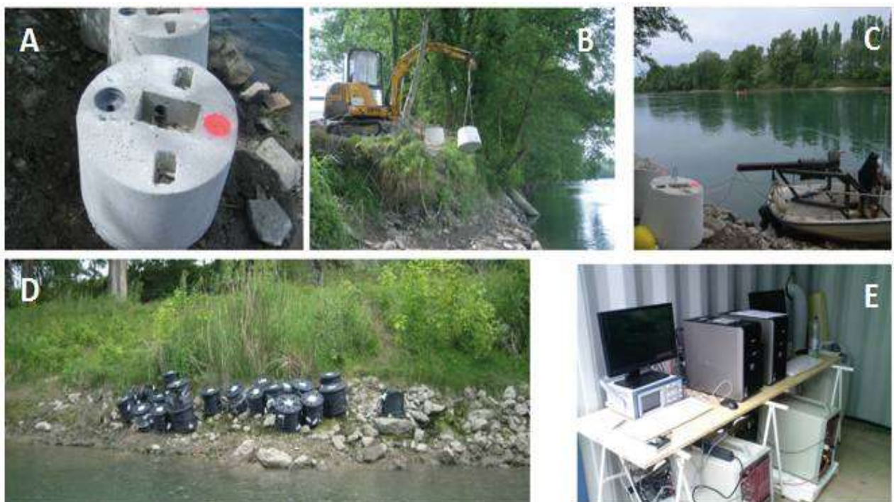
Figure 29 : déploiement du matériel HTI sur le site d'étude (le Rhône au droit du CNPE de Bugéy). Des blocs béton de 300 kg sont déposés au fond du Rhône en des positions précises déterminées pour maximiser la surface d'écoute du système (A, B et C). Les hydrophones installés dans chaque bloc de béton sont reliés par des câbles (D) à une centrale d'acquisition implantée dans le CNPE (E).
