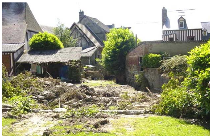
Figure 23 : photo d'endommagement dû au débordement du Ruisseau des Ouies, à Touques (centre bourg)
