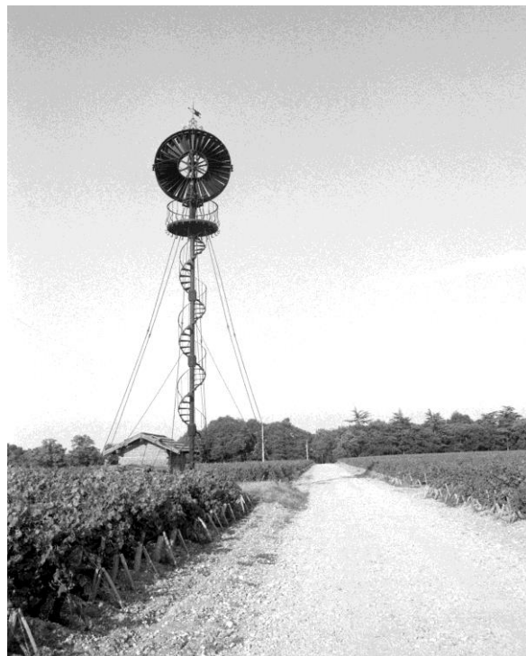
Fig. 9 : Eolienne du château de Lanessan, détruite en 1999 (© SRPI, Région Aquitaine).
