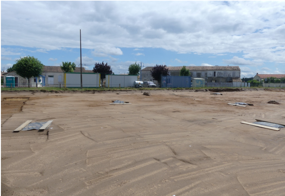
Fig. 15 - Vue du site depuis le sud-ouest au terme du décapage. Les structures sensibles ont été recouvertes par une bâche. Cliché G. Seguin© Éveha 2021.
