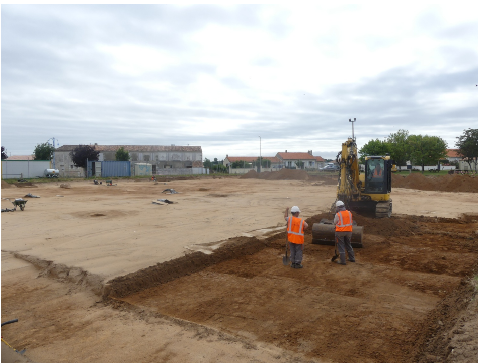
Fig. 16 – Décapage de contrôle afin d'atteindre l'US 1002 sur l'intégralité de l'emprise. Cliché G. Seguin© Éveha 2021.
