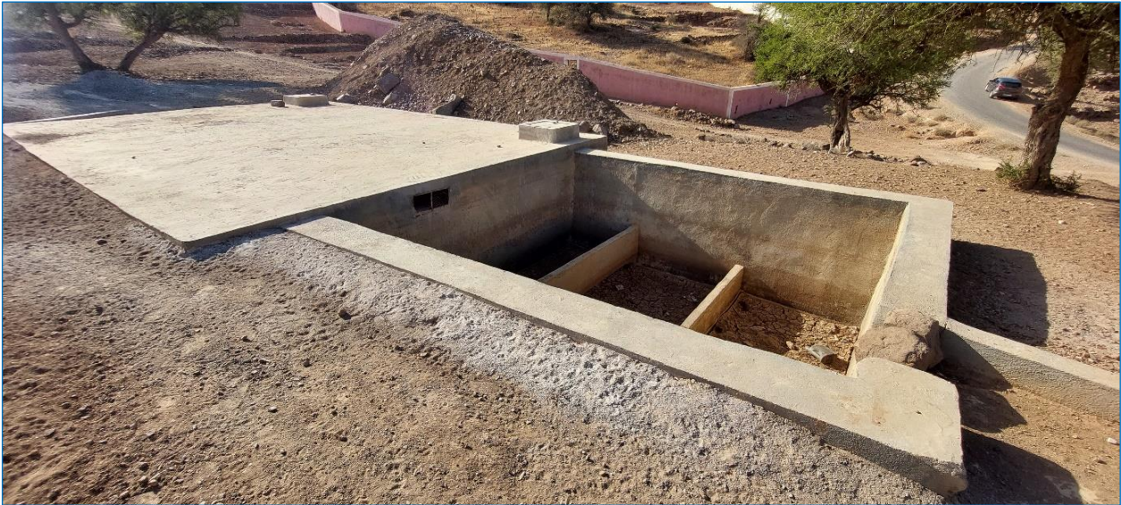
Fig. 7 : Exemple de notfia construite en béton et béton armé [Anti-Atlas occidental, Oct. 2021]
