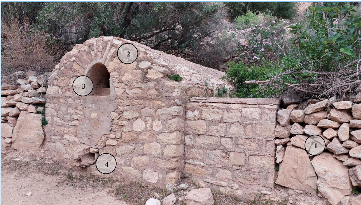
Fig. 8 : Exemple de notfia conçue pour être utilisée en irrigation [Agadir Ida-Outanane, mai 2022]
