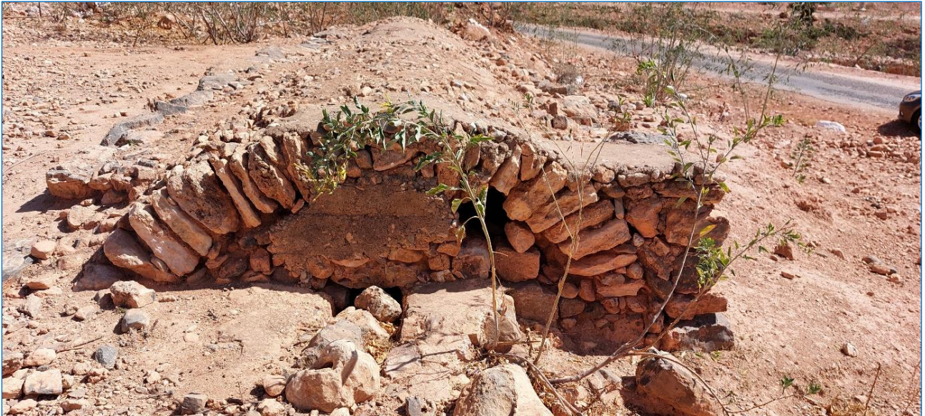
Fig. 6 : Couverture voutée en pierre naturelle d'une notfia en état de dégradation avancé [Anti-Atlas occidental, Oct. 2021]
