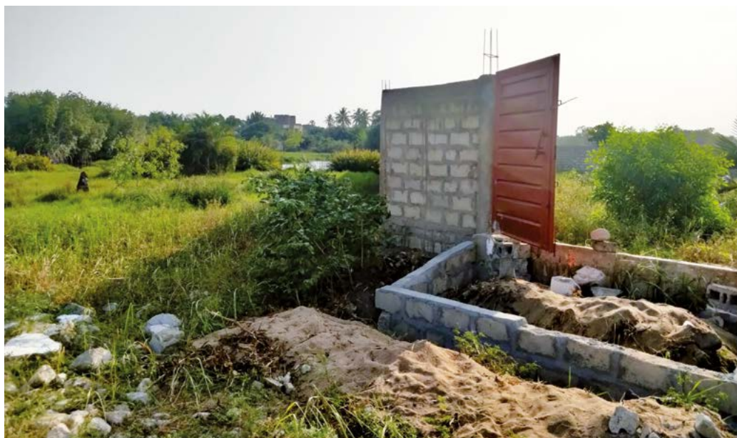
Morcellement et parcelle clôturée en bord de lagune, Togbin, Bénin, 2021 © Simonneau
