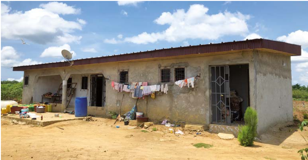
Construction sur un nouveau lotissement, Djimini-Koffikro, Côte d'Ivoire, 2023 © Colin
