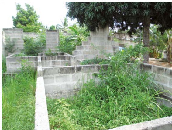
Construction de lotissement, Mapinga, grande périphérie de Dar es Salaam, Tanzanie, 2019 © Schlimmer
