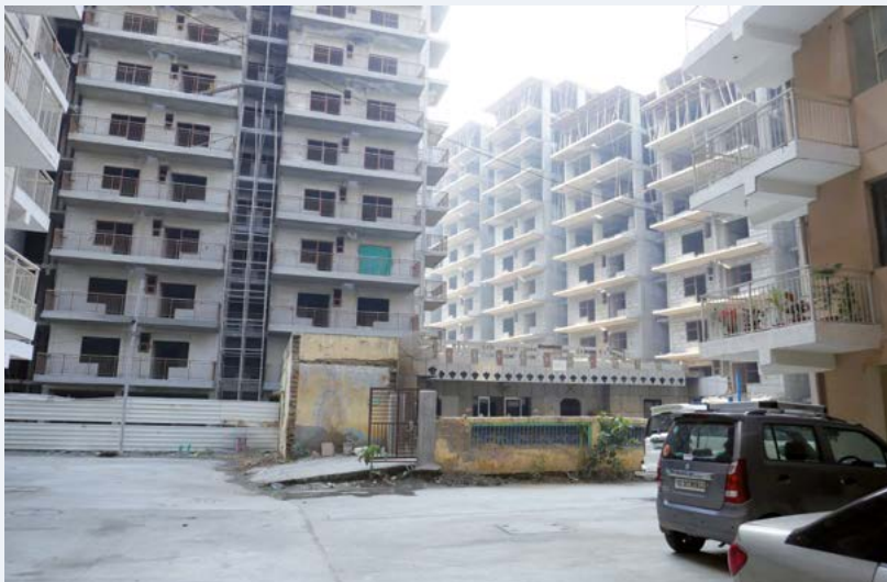
Immeubles construits par les trois frères et leur maison de village d'origine au centre, Faridabad, Inde, 2020 © Bon
