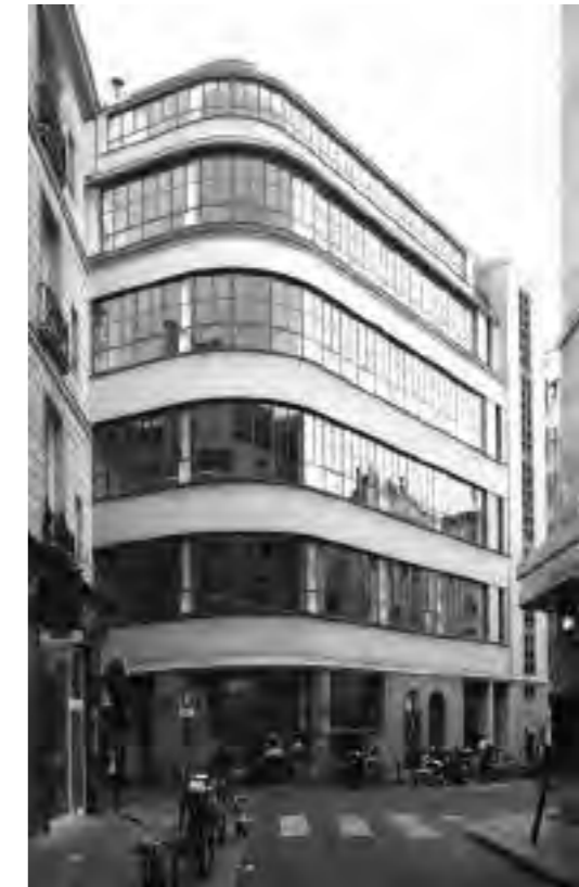
03 Roger-Henri Expert, Atelier building for the École des Beaux-Arts in Paris, Rue Jacques Callot, 1933. Today a site of ENSA Paris-Malaquais (Photograph: Dan Teodorovici).
