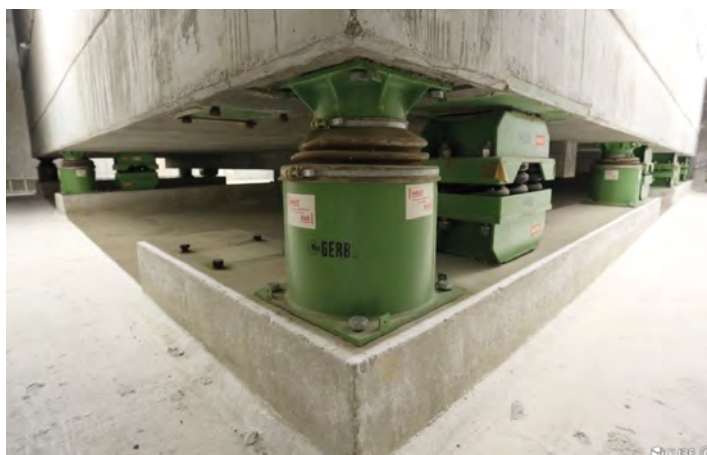
Laboratoire d'interférométrie optique, d'holographie et d'imagerie optique (bunker) constitué d'un bloc de béton de plusieurs centaines de tonnes reposant sur 64 ressorts et amortisseurs (ICube, Université de Strasbourg et CNRS).
