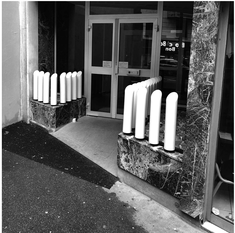
Fig. 2 – Dispositif urbain défensif pour éviter tout usage informel devant une entrée d'immeuble à Paris.
