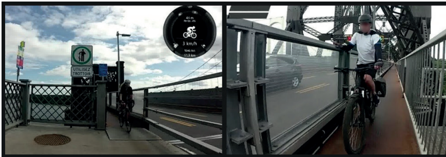
Figure 11 Passage étroit du pont de Québec
