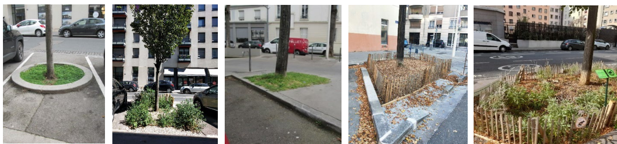
Photos de la typologie ( 1 et 3) des fosses d'arbres existantes et de l'aménagement résultant en arbres de pluie ( 2, 4 et 5).
