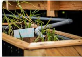
Phytoépuration eaux usées
