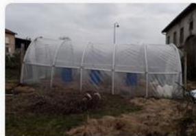
Serre à structure PVC
